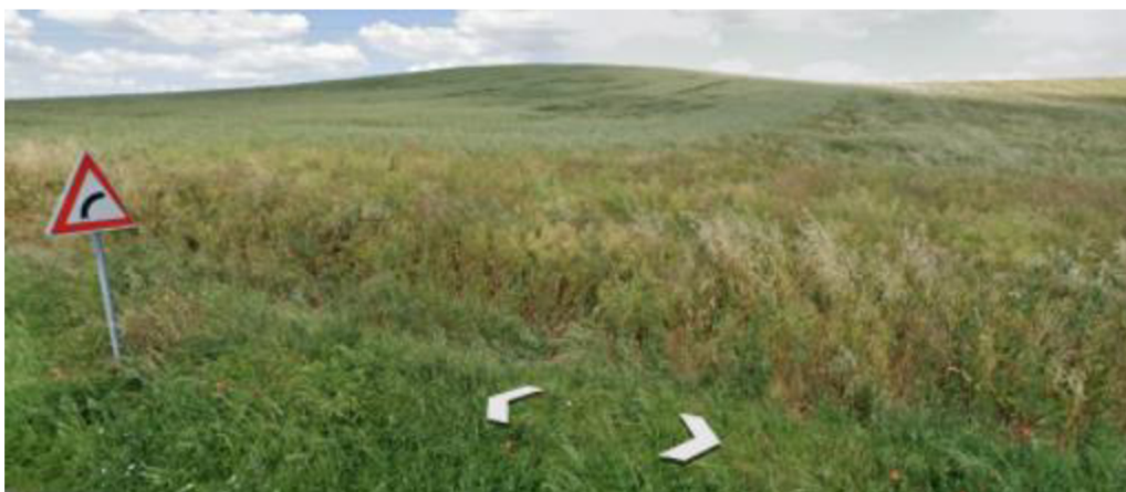
Obr. 5 Na obrázku je viditelná značka, která má část své nosné konstrukce zavalenu erodovaným materiálem, příkop na odvod vody mezi polem a silnicí téměř zmizel, dále si lze všimnout vysokého sklonu a délky svahu, lze odhadnout i způsob osevu po spádnici (google maps, 2021).
