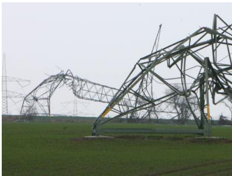
Obrázek 1.4 – Spadlé vedení vysokého napětí, orkán Kyrill, 2007, Německo
