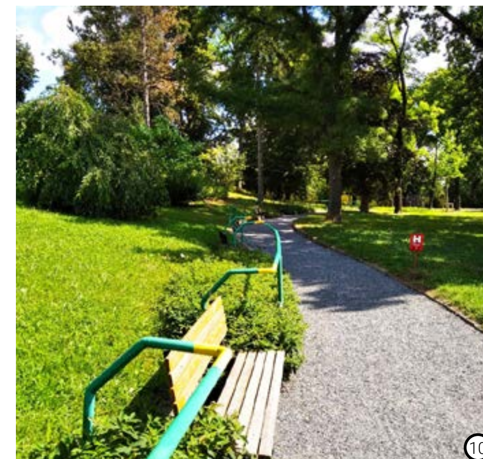
Obr. 50: Kontrastní vodící linie a obrubníky lemující cesty
