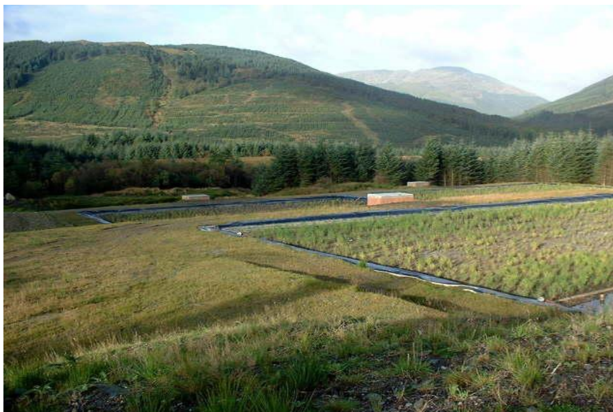
Fotografie č. 2: Kořenová skládka ve Skotsku. V pravé části snímku je porost rákosí, který je využíván k čištění. Zdroj: Associates landfills, 2010.
