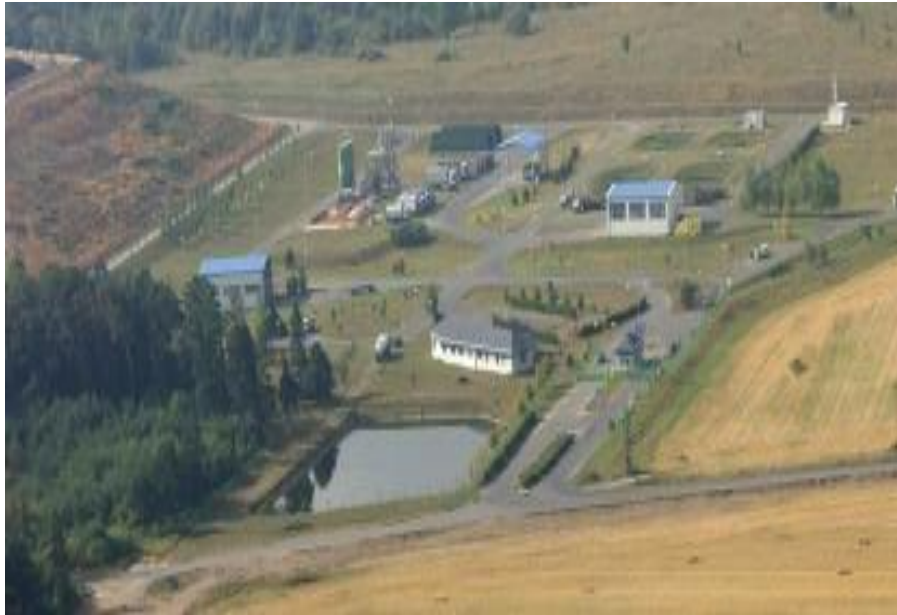
Fotografie č. 4: Skládka skupiny S-NO v Benátkách nad Jizerou, kterou provozuje firma AVE. Uprostřed snímku je vidět technické zařízení skládky a jímka pro jímání skládkové vody. V levé části snímku je skládkové těleso. Zdroj: Avez, 2010.
