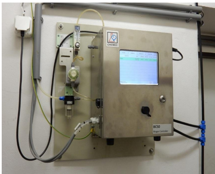
Obr. 13. Analyzátor plynu, BPS Agrodružstvo Lhota pod Libčany [foto vlastní].
