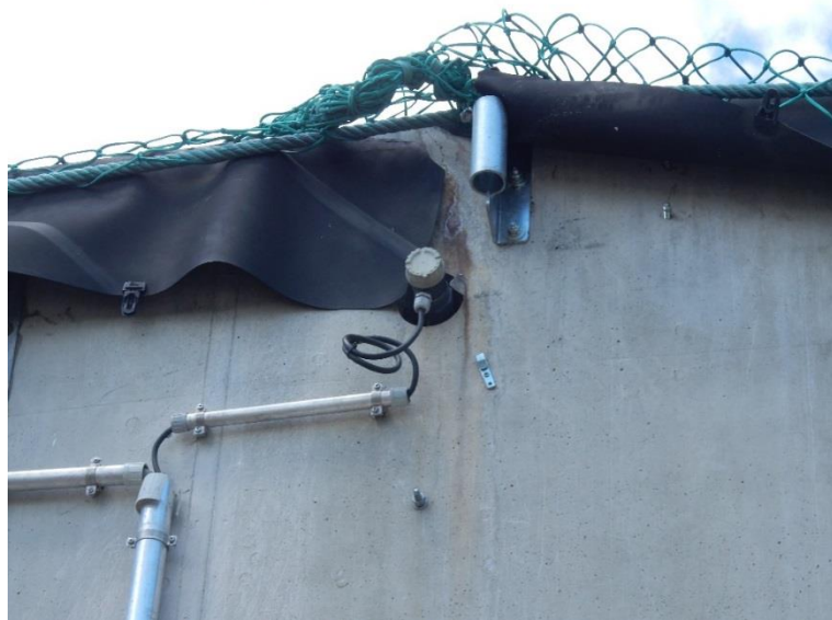
Obr. 30. Snímač maximální hladiny ve skladovací jímce [foto vlastní].
