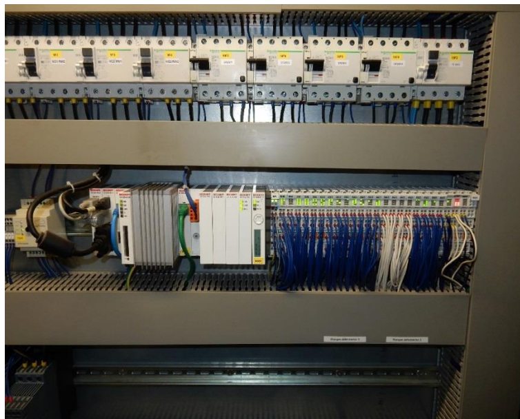
Obr. 24. Řídicí automat Beckhoff [foto vlastní].
