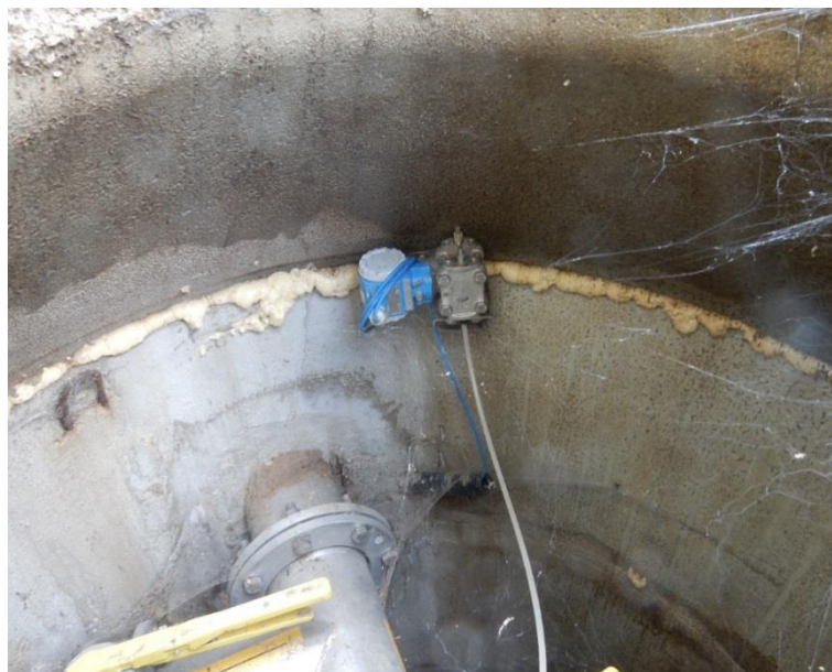
Obr. 12. Tlakoměr, BPS Agrodružstvo Lhota pod Libčany [foto vlastní].
