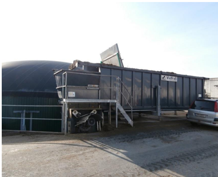
Obr. 21. Fermentor s plynovým zásobníkem Biolene a dávkovacím zařízením Vielfrass® [foto vlastní].
