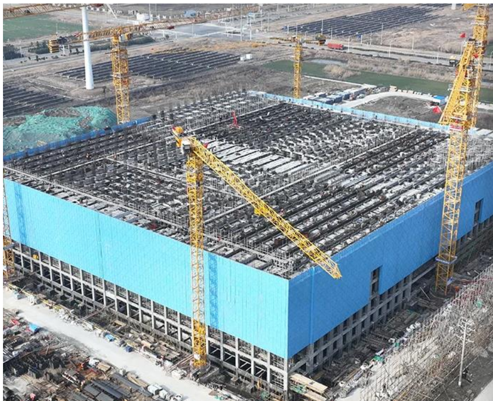
Obr. 1.24 EVx Realizace uložistiště, Rudong, China [39]
