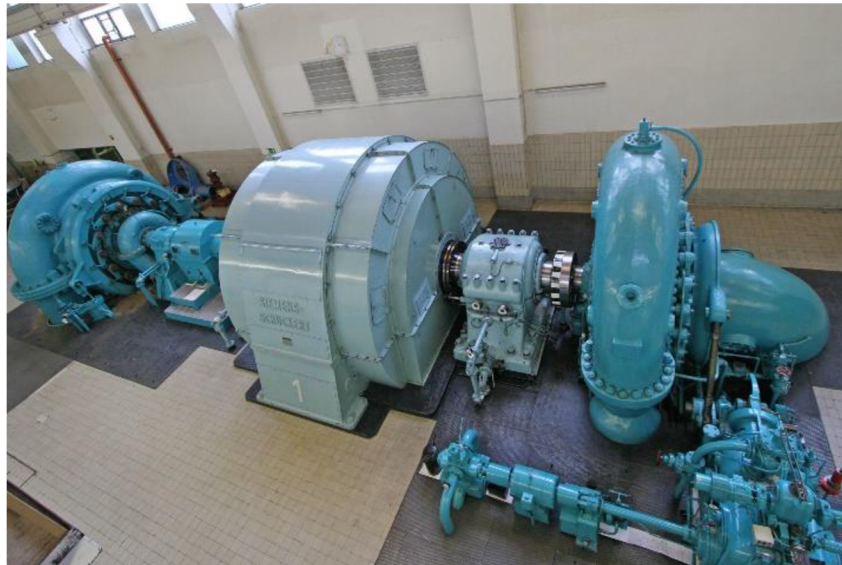
Obr. 2.2 Třístrojové horizontální uspořádání [50]
