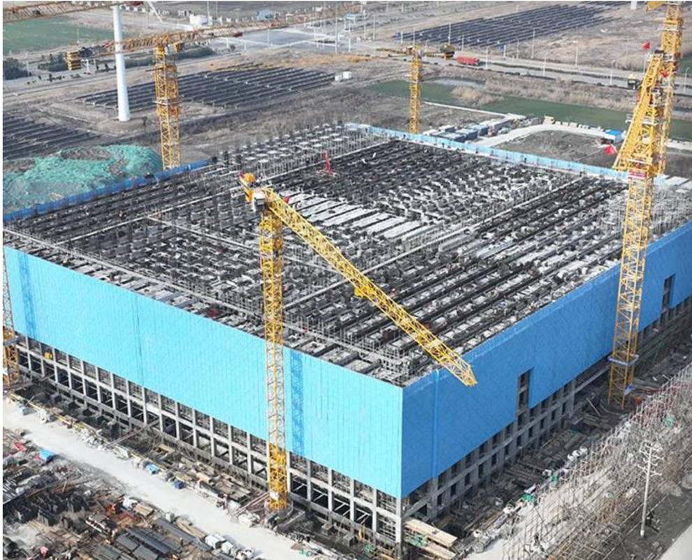
Obr. 1.24 EVx Realizace uložistiště, Rudong, China [39]
