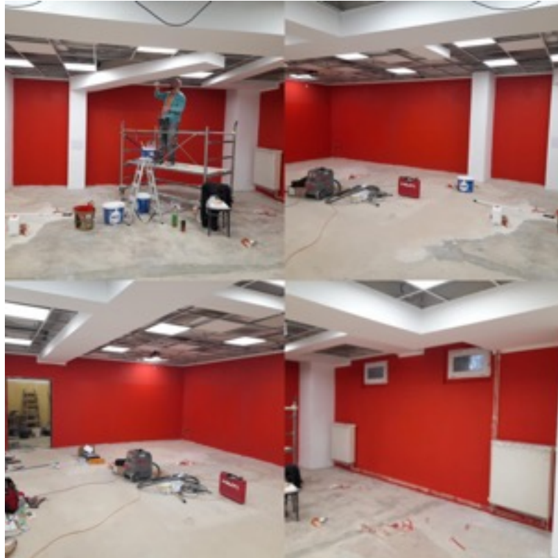
Image n° 8 Construction de nouveaux locaux (M. Gregor, 2021)
