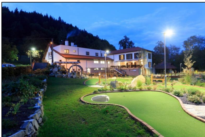
Obr. 3 1 Hotel a restaurace U Vychopňů pohled od minigolfu
