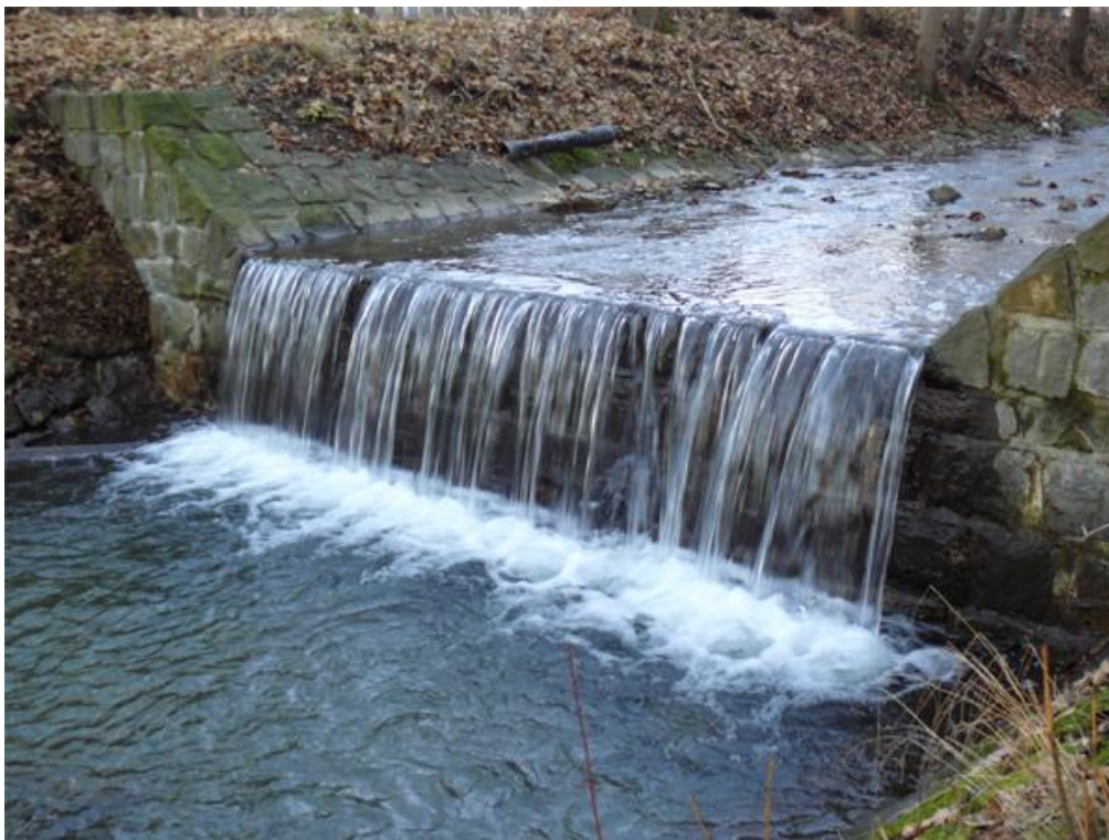
Obrázek 5: Kamenný stupeň s vytvořenými „křídly“ neumožňuje migraci druhům s malou migrační výkonností
