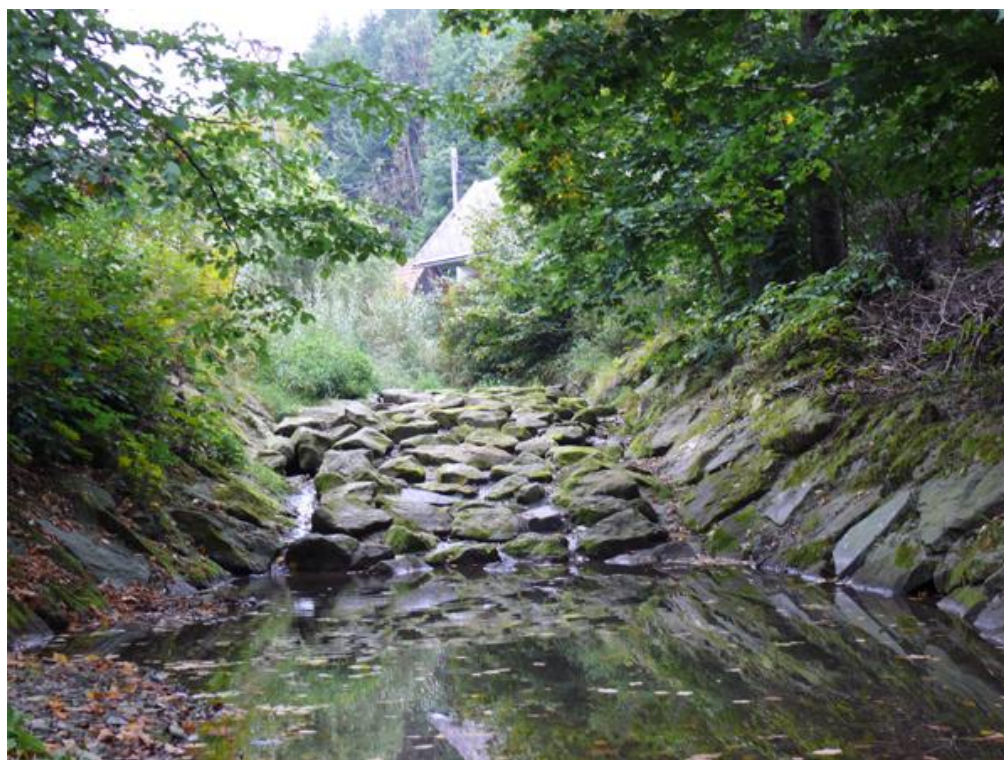
Obrázek 6: Kamenný skluz umožňuje protiproudovou migraci
