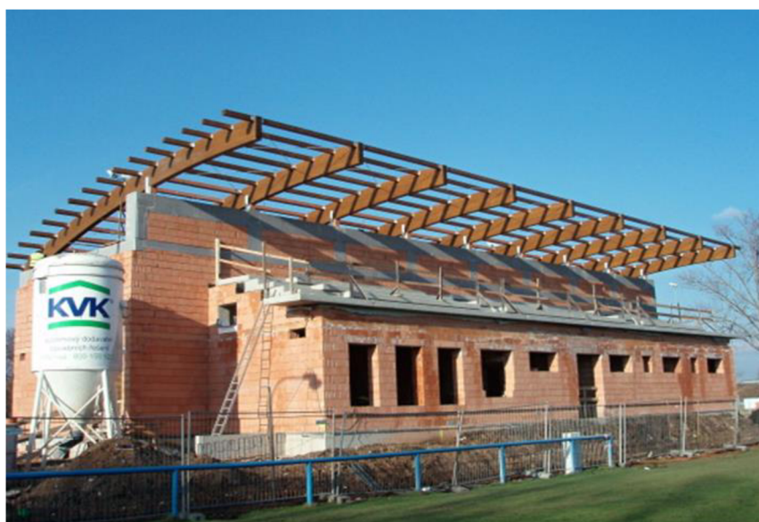
Obrázek 10 Stavba nové tribuny 2014
