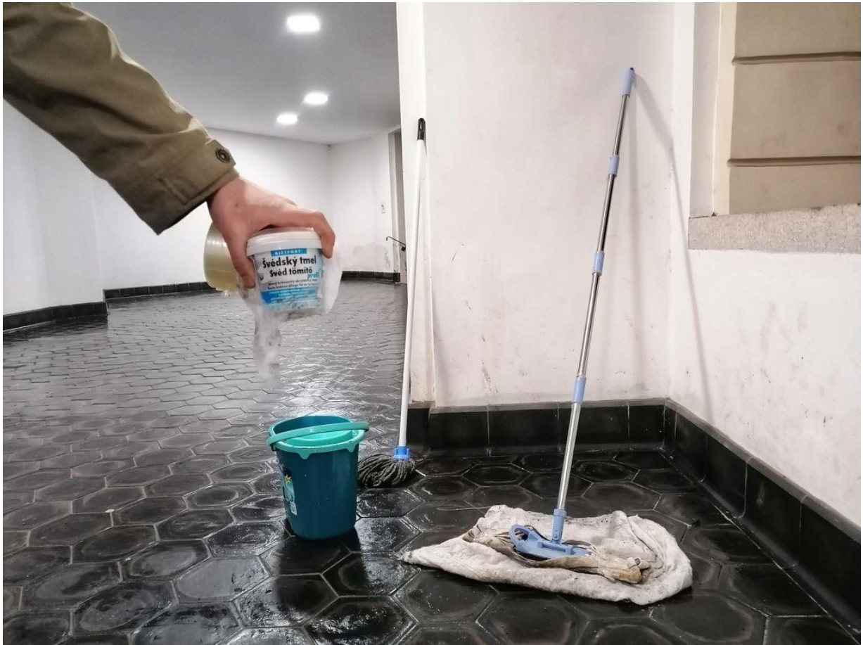
úklid a tmelení zdí průchodu 1
