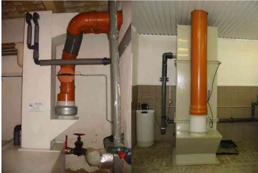
Obr. 2-5 Vertikální provzdušňovače FUKA [38]
