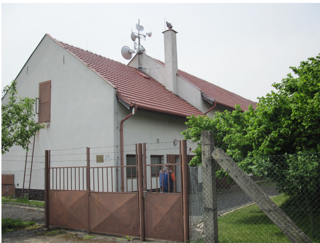
Obr. 4-2 Objekt úpravny vody
