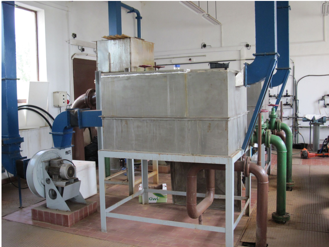
Obr. 5-1 Dvojice horizontálních aerátorů INKA
