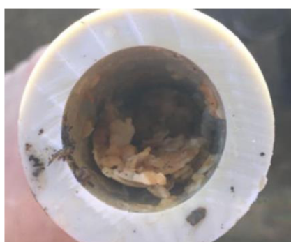
Obr. 3: Zanášení plastového potrubí [13]
