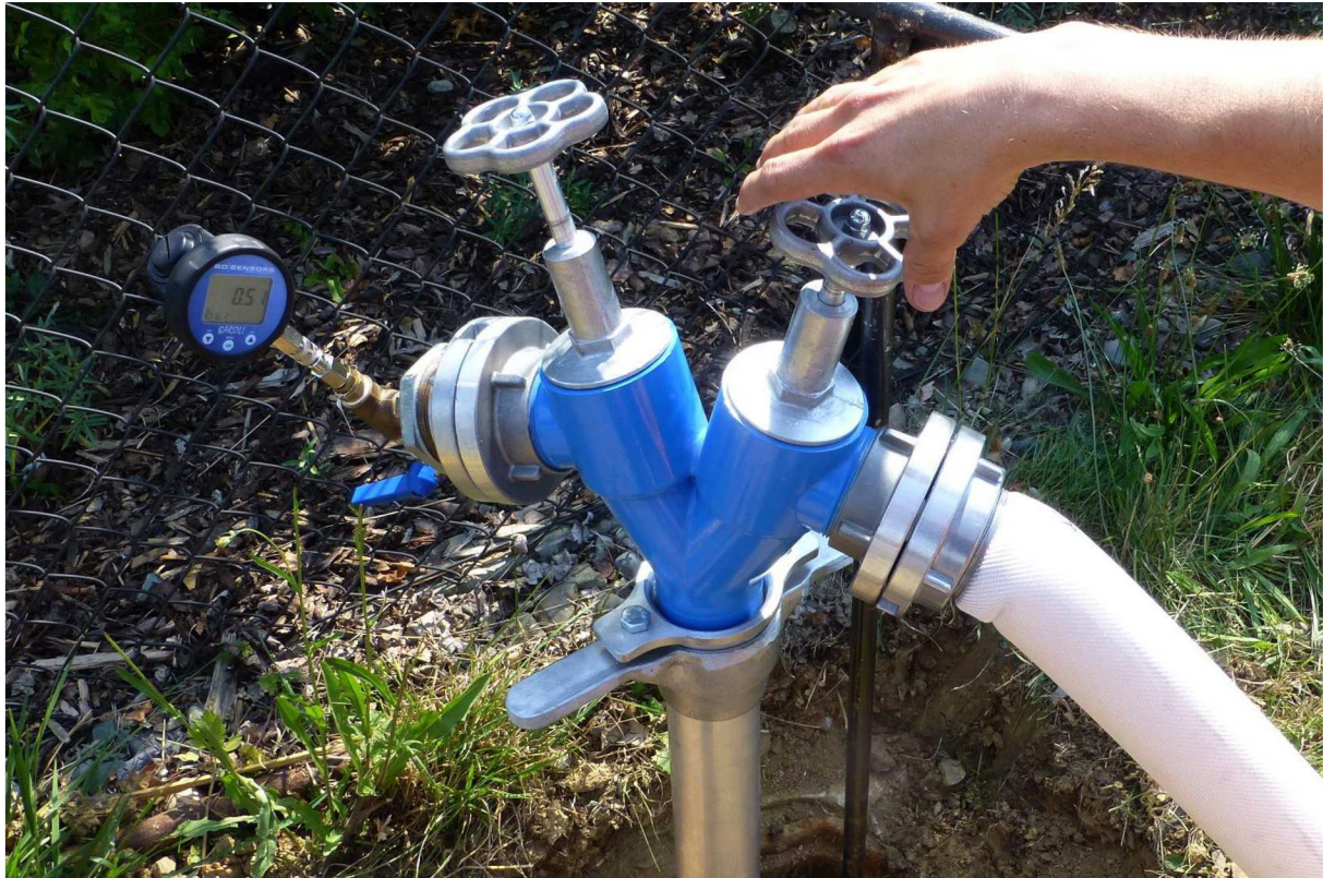
Obr. 10: Osazení tlakového čidla Baroli na hydrantovém nástavci při proplachu vodovodní sítě
