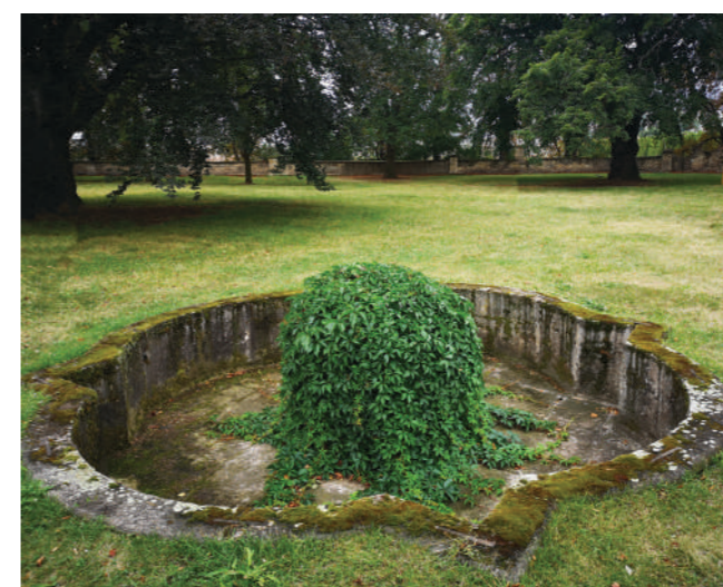
Obrázek 29 - Vypuštěná kašna na spodním parteru (Foto autorky 2020)
