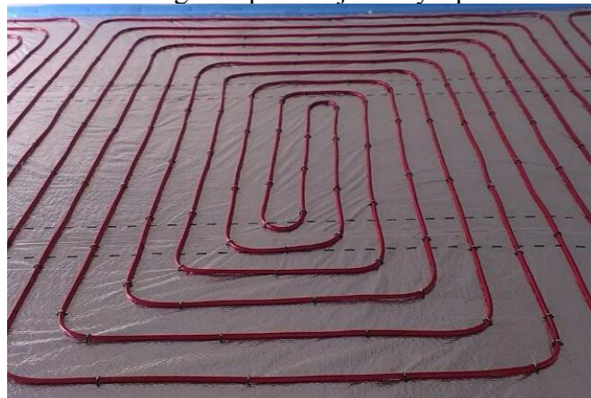
Obr. 12 - Meandrové uloženie [22]
