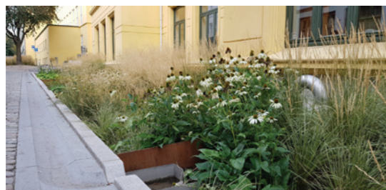
Obr. 18: Systém svedení vody do dešťových záhonů (Vysoký 2018)
