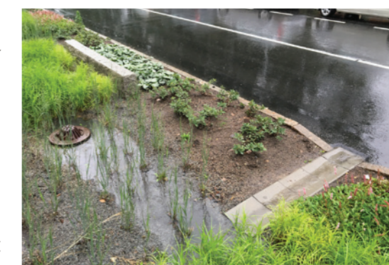
Obr. 16: Systém svedení vody do dešťových zahrad (SZKT)
