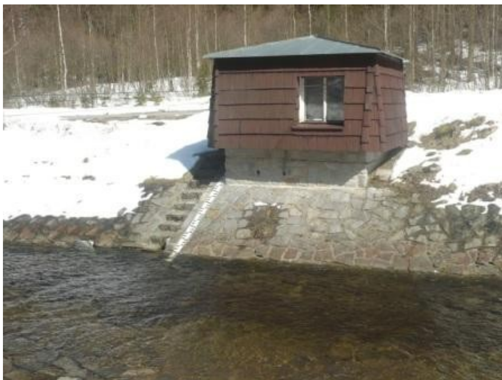
Obr. 19: Vodoměrná stanice pod PVE (Zdroj: fotografie autora).
