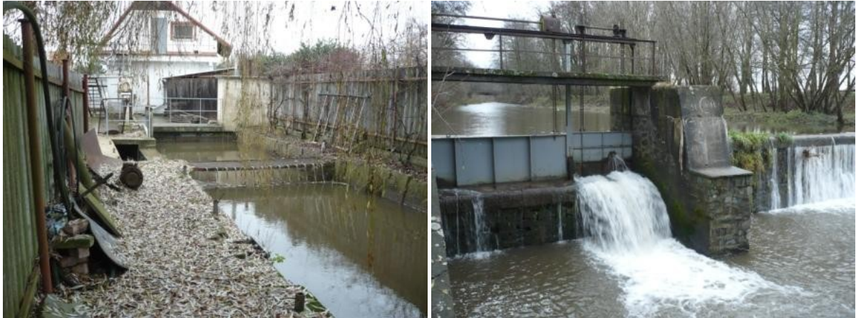
Obr. 10: Budova elektrárny včetně hrubých česlí a jez zásobující vodou derivační kanál (Zdroj: fotografie autora)
