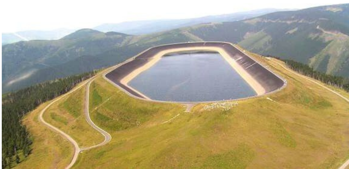
Obr. 17: Horní nádrž (Zdroj: ČEZ)
