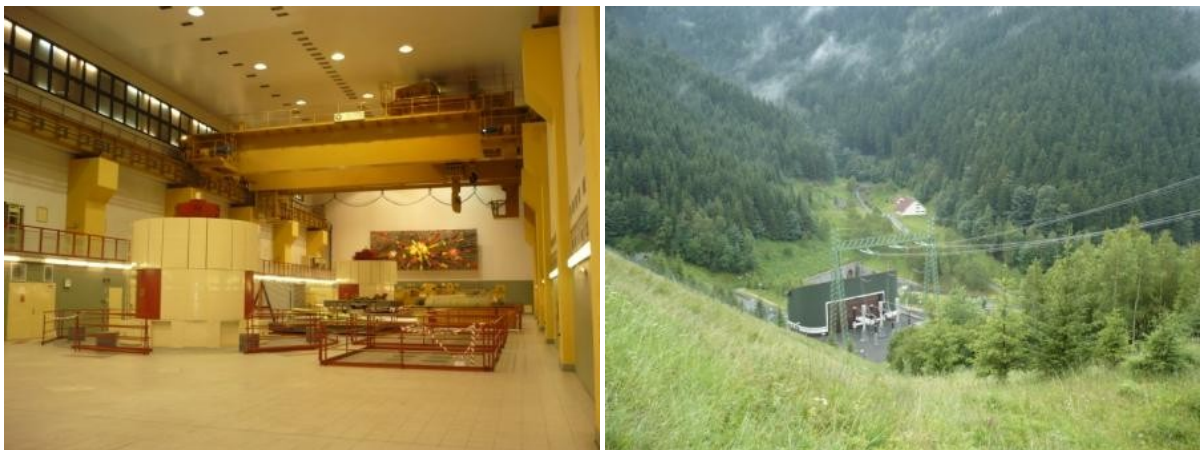
Obr. 16: Část kaverny vyražené ve skalním masivu a zapouzdřená rozvodna 400 kV (Zdroj: fotografie autora).
