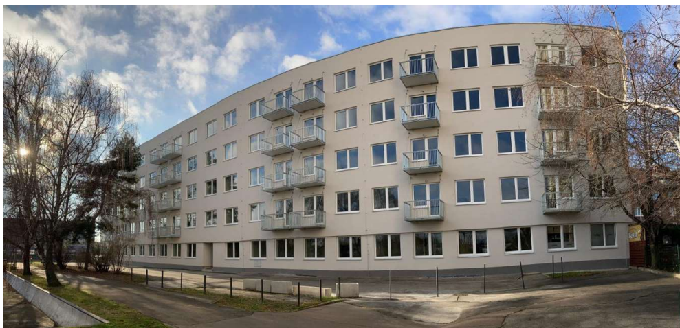
Obrázek 4 – Kompletní rekonstrukce bytového domu
