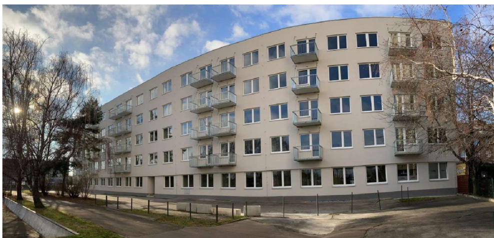
Obrázek 4 – Kompletní rekonstrukce bytového domu
