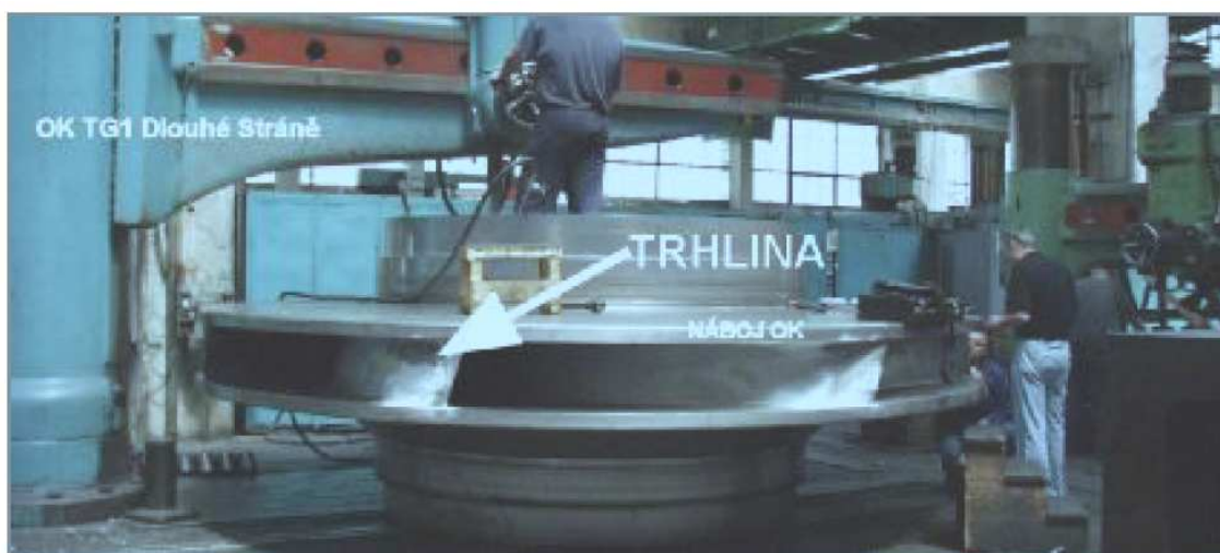
Obr. 25 Sedmilopátkové oběžné kolo s trhlinou
