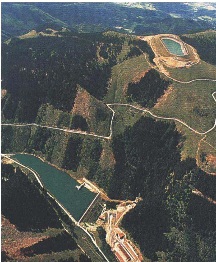
Obr. 28 PVE Dlouhé Stráně – letecký pohled
