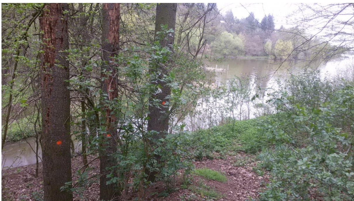
Fotodokumentace č. 4 – Předzdrž VN Plumlov (fotografie autora)
