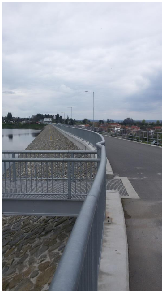
Fotodokumentace č. 7 – Návodní svah VN Plumlov (fotografie autora)
