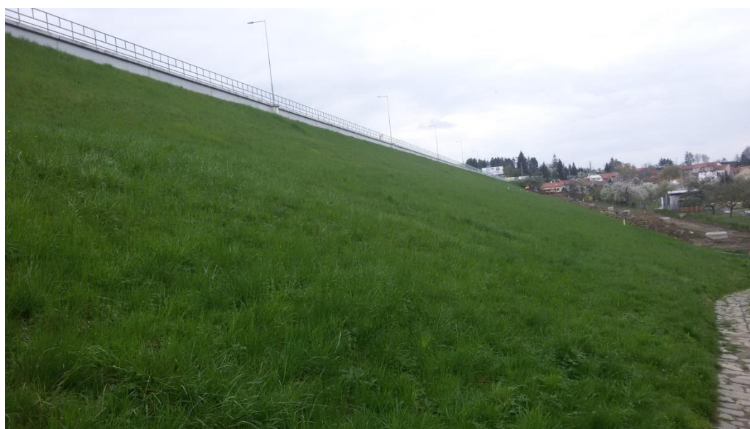
Fotodokumentace č. 8 – Vzdušný svah VN Plumlov (fotografie autora)
