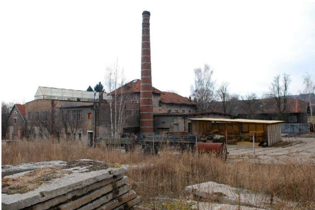
Fotografie č. 2 Areál Strojbalu ( Adamová, 2012 )
