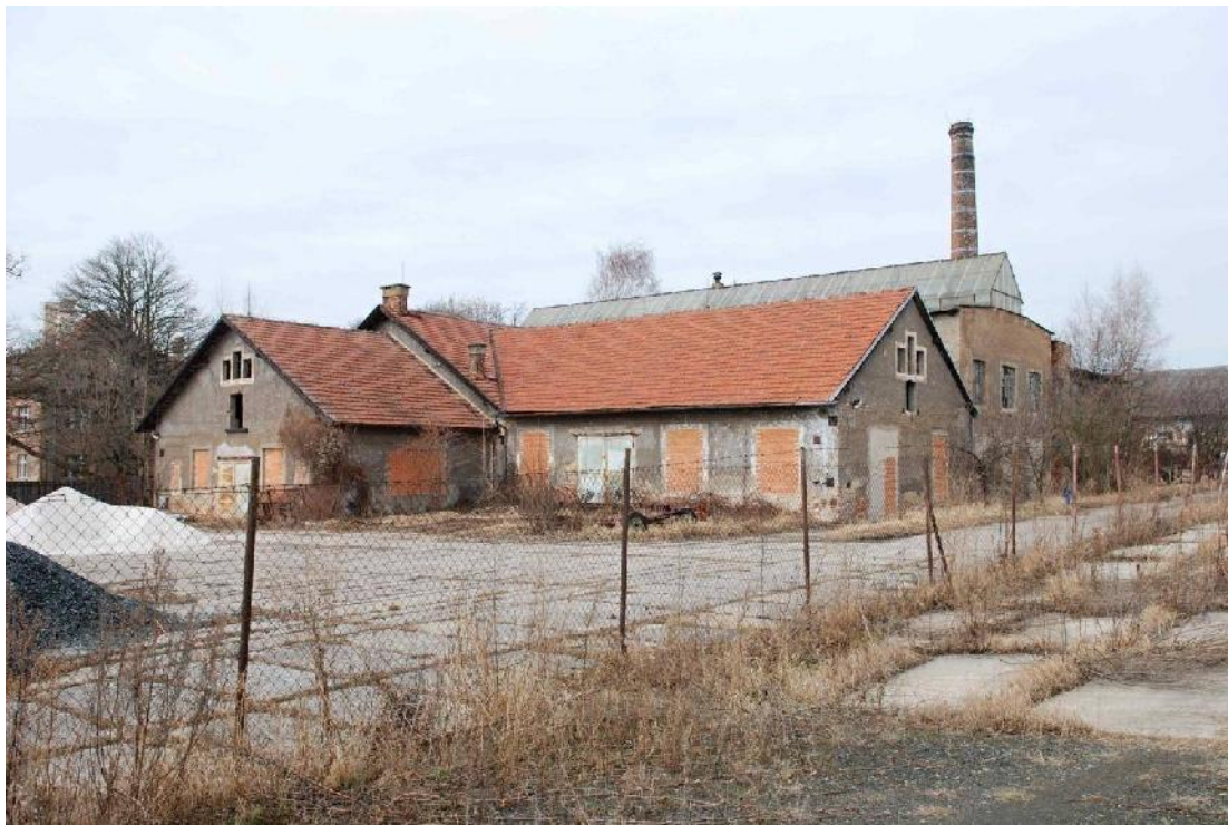
Fotografie č. 1 Areál Strojbalu ( Adamová, 2012 )
