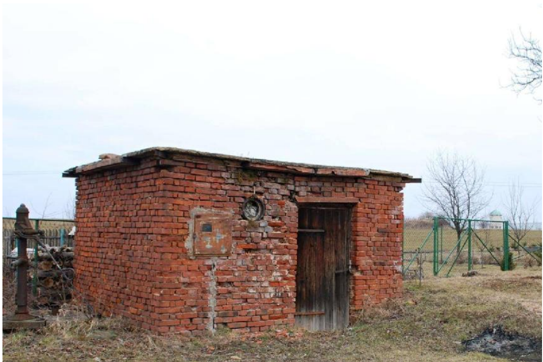
Fotografie č. 6 Studna Molitorov ST-M (v pozadí KJV) (Adamová, 2012)
