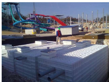
Foto z montáže nádrží
