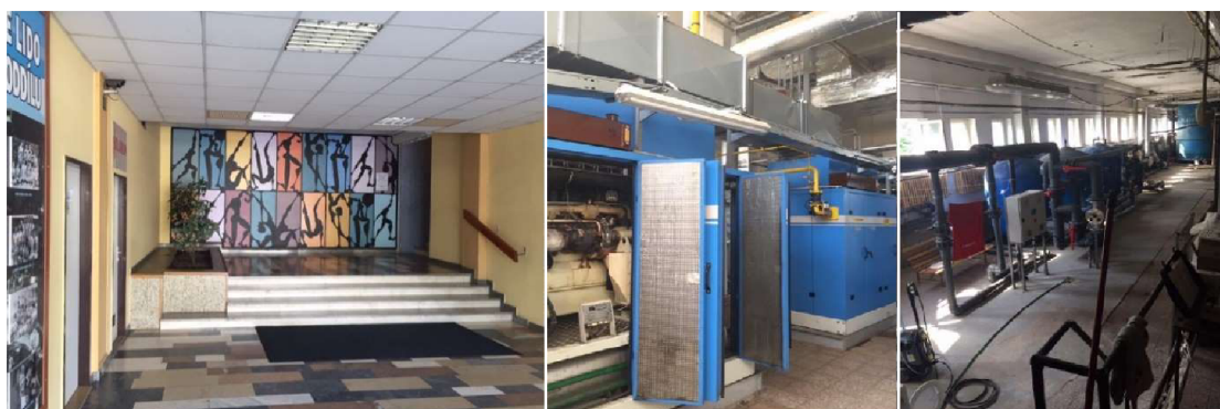
Obr. 7.4 Přízemí objektu (vstupní hala, tepelné hospodářství, technologie úpravy vody)
