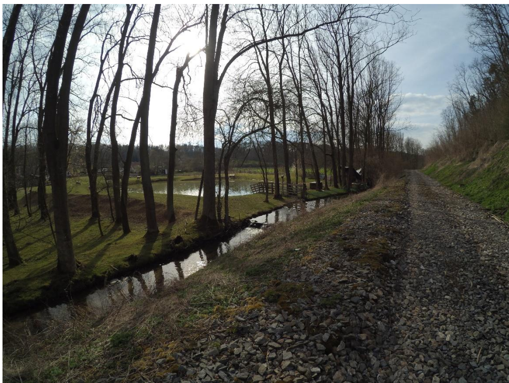
Foto č. P9: Vodní nádrž na soukromém statku (začátek obce Lhotka)
