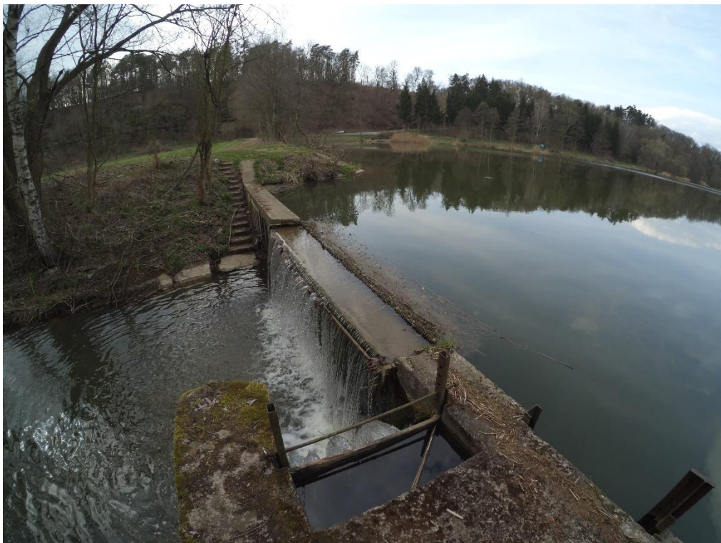
Foto č. P1: Stavidla vodní nádrže Lhotka
