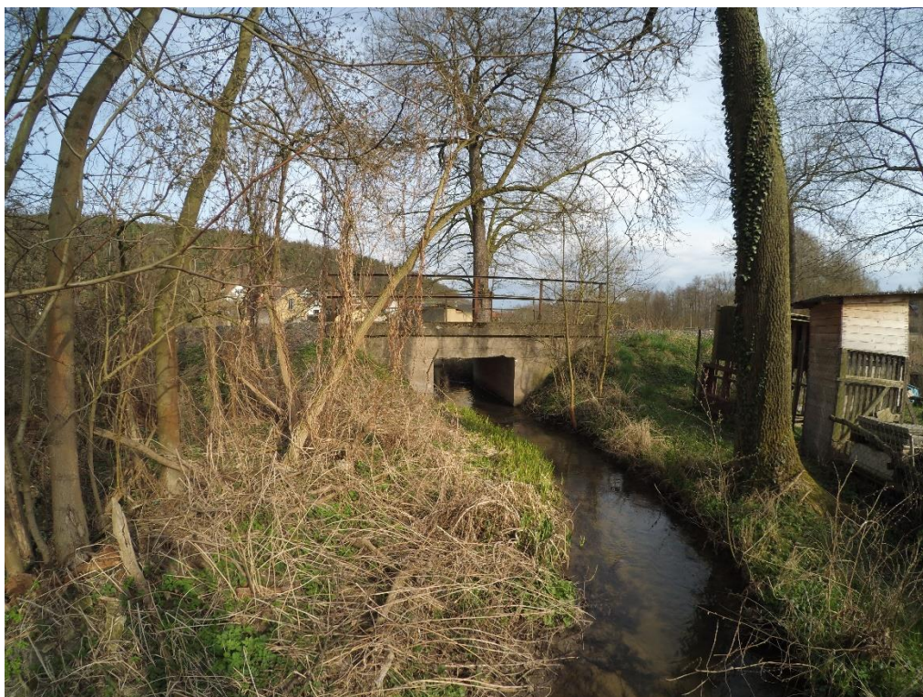
Foto č. P11: Další mostek železniční trati v obci Lhotka
