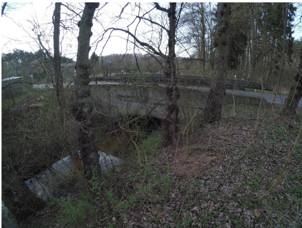
Foto č. P6: Klenutý betonový mostek hlavní pozemní komunikace
