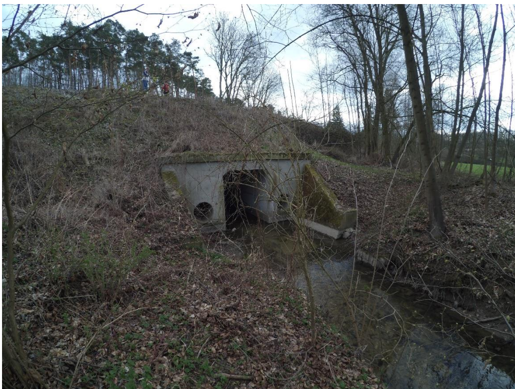
Foto č. P3: Propustek železniční trati u turistického centra
