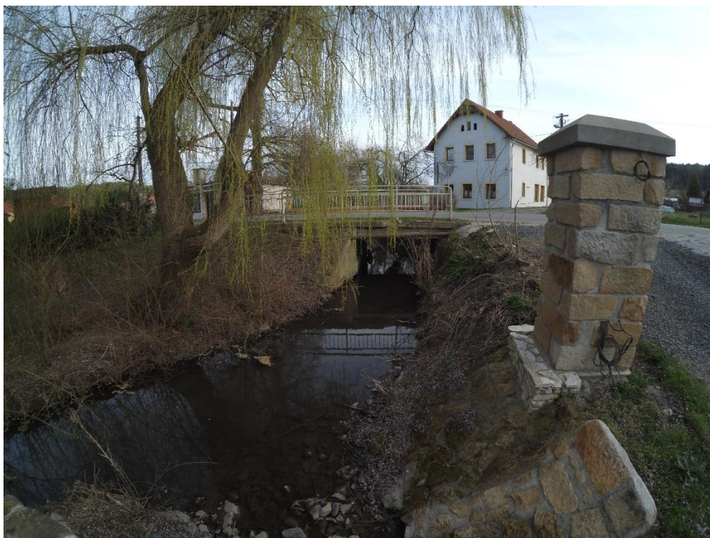
Foto č. P18: Mostek hlavní pozemní komunikace v obci Hled'sebe (konec zájmového úseku)
