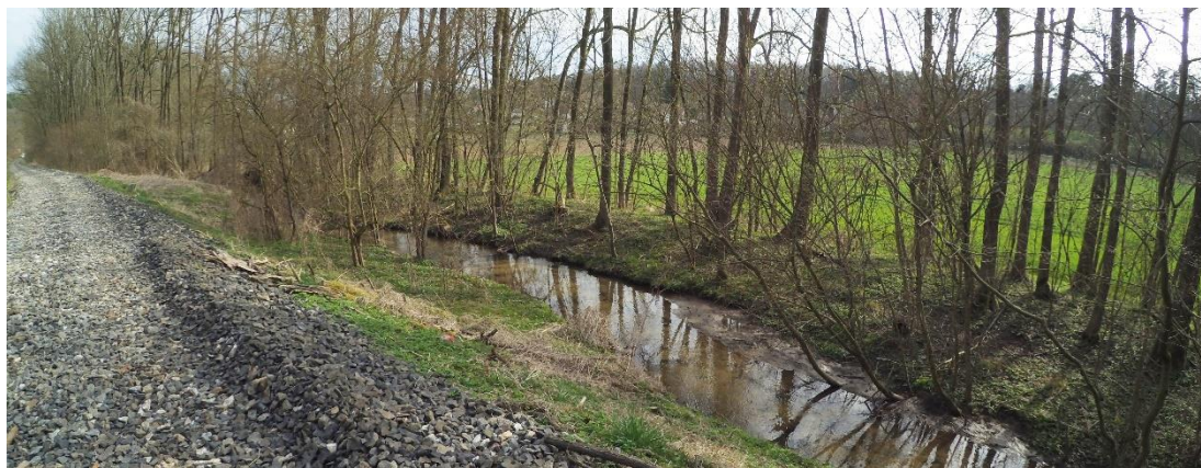
Obr. č. 17: Pšovka v části kopírující tvar náspu železničního tělesa
