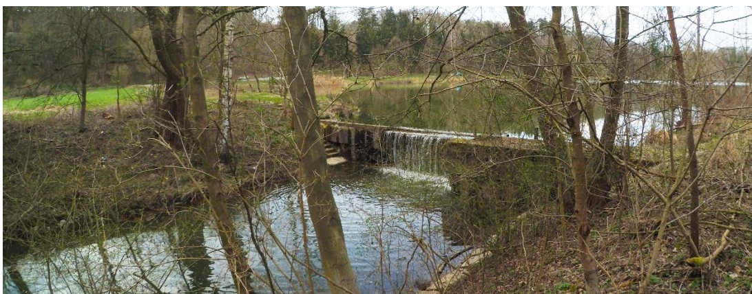
Obr. č. 18: Stavidla vodní nádrže Lhotka
