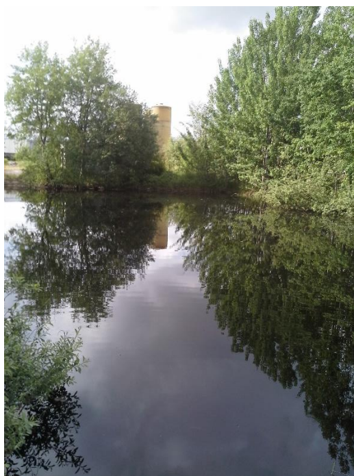
Příloha 4: Nádrž v areálu skládky v Lhenicích (v pozadí nadzemní laminátové nádrže se skladovanými oleji s obsahem PCB) (foto M. Let)
