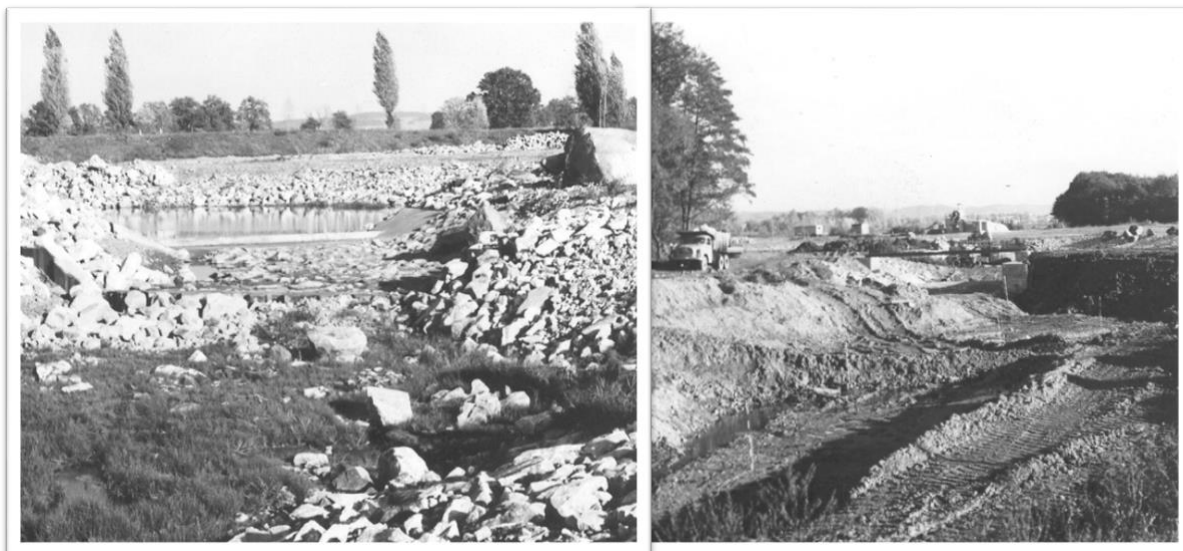
Obrázek 66. Na fotografii vlevo je vidět průběh stavby úseku za stavidlem. Na fotografii vpravo je vidět průběh stavby dolního úseku těsně před kolovadlem. Osobní archiv Jakuba Prühera.
