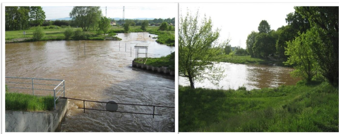
Obrázek 68. Na obou fotografiích je vidět původní vstupní bazének USD v Českém Vrbném. Jednalo se o rozsáhlou vodní plochu zcela bez vln a peřejí hned na začátku umělé slalomové dráhy. Bazének sloužil především k osvojování základních kanoistických technik začátečníků a k rozježdění závodníků. Sporadicky byl využíván i pro kanoepolo. Osobní archiv Jakuba Průhera.
