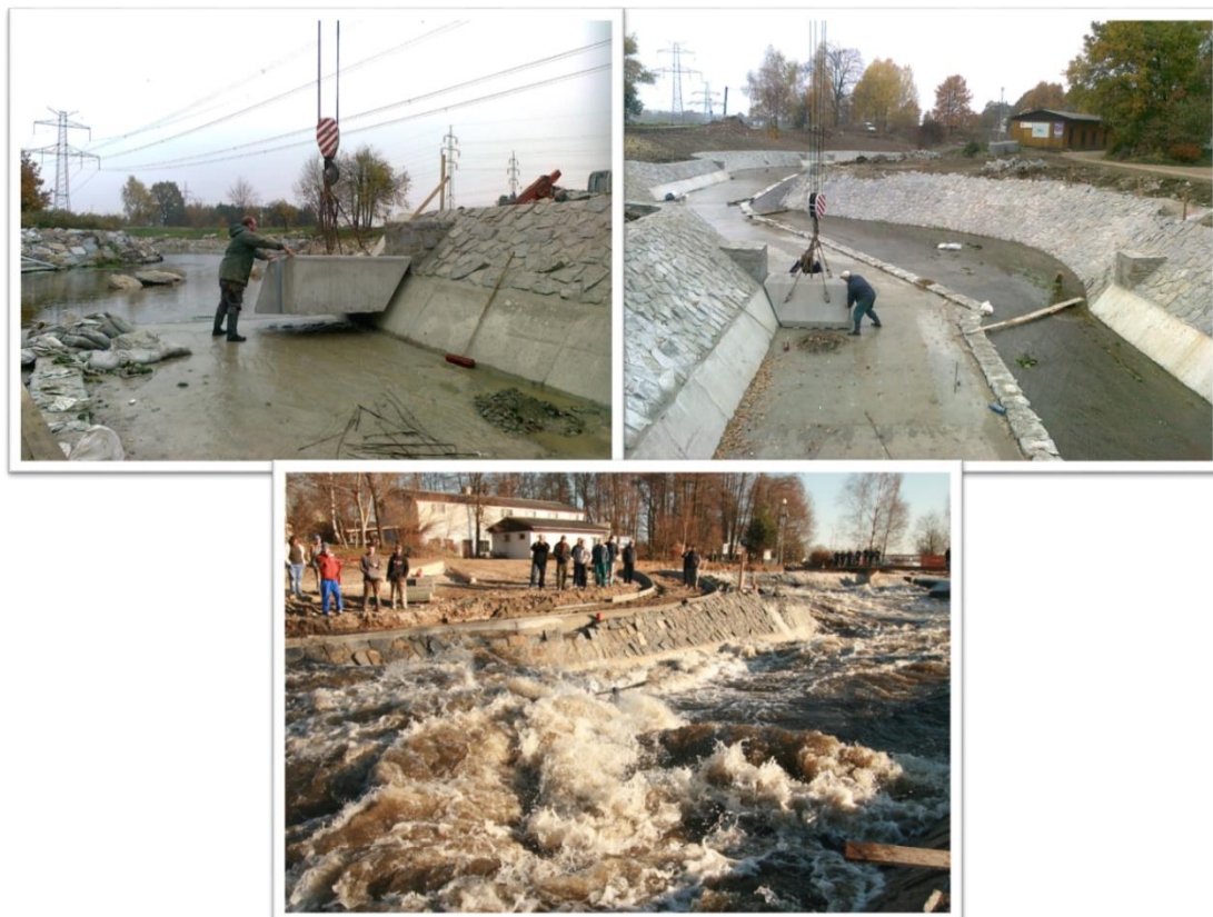
Obrázek 82. Tyto fotografie jsou už z dokončovacích prací. Umísťování těžkých betonových překážek probíhalo za pomoci jeřábu. Tyto betonové překážky jsou pouze základem. Hlavní část překážek tvoří ovšem hlavně mobilní plastové bloky. Dole je vidět prvosjezd trati kdy v ní byly pouze betonové překážky. Osobní archiv Jakuba Prühera.
