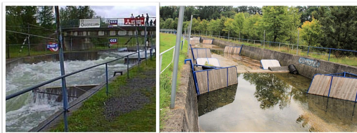
Obrázek 59. Na fotografii vlevo je vidět slalomová dráha Trnávka, která je jednou z nejtěžších slalomových tratí v Evropě v plném nátoky vody. Na fotografii vpravo je vidět jednoduchý typ překážek umístěných v betonovém korytě. Převzato z http://www.raft.cz/kanaly.aspx .
