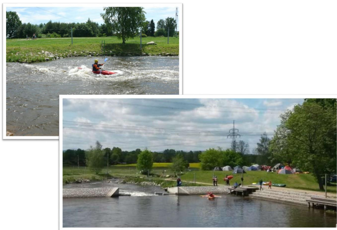
Obrázek 83. Na fotografiích je vidět první úsek opravené slalomové dráhy. První dvě kaskády jsou upravené pro začátečníky. Nejsou obtížné a pod nimi vždy následuje klidnější úsek. Nové jsou široké vracáky pod druhou kaskádou. Osobní archiv Jakuba Prühera.
