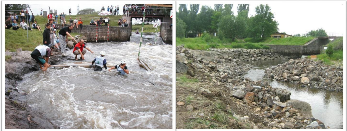
Obrázek 74. Na fotografii vlevo je typický obrázek chytání zvrhlých lodí pod Kolovadlem . Vpravo je vidět Kolovadlo bez vody. Velké vracáky zde tvořila právě velmi členitá konfigurace dna kanálu. Osobní archiv Jakuba Průhera.
