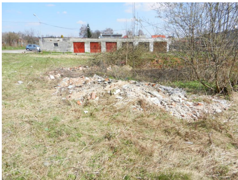
Foto č. 19 - Nelegální skládka č. 8, Bývalý hospodářský sklad, ul. Za Vápenkou, Trutnov- Horní Předměstí,
