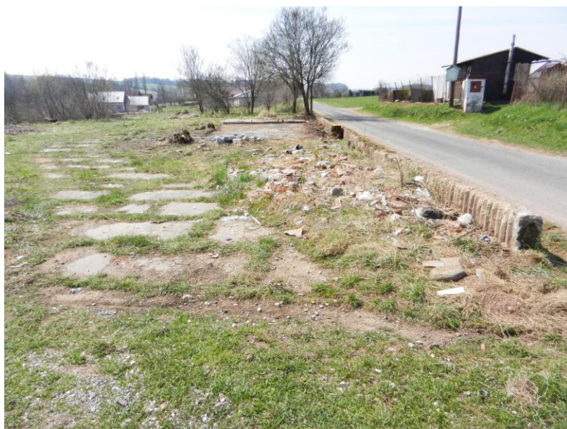
Foto č. 20 – Nelegální skládka č. 9, Plechové boudy, ul. Za Vápenkou, Trutnov- Horní Předměstí, na dřívějším místě skladů se nachází stavební odpad
