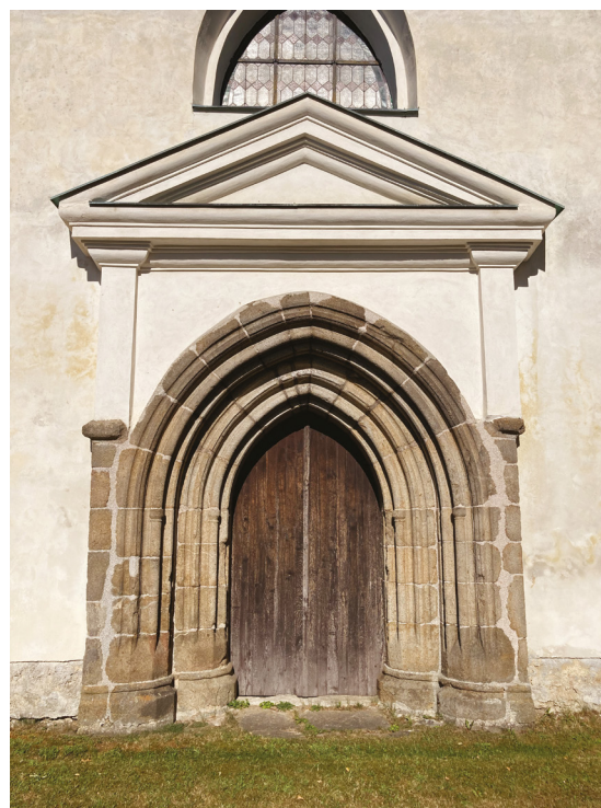
47/ Portál v západním průčelí.
