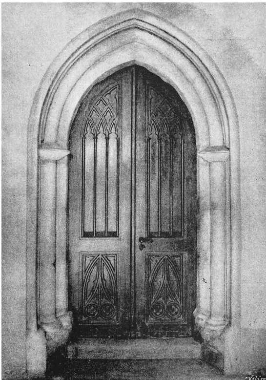
66/ Portál s talířovými prstenci v západním průčelí lodi, dnes v podvěží.
