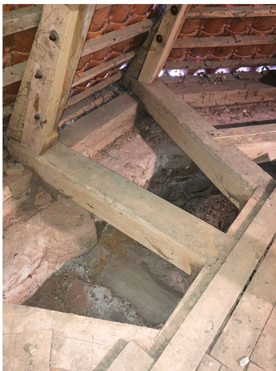
43/ Klínovitý blok vystupující z koruny zdiva v závěru presbytáře.
