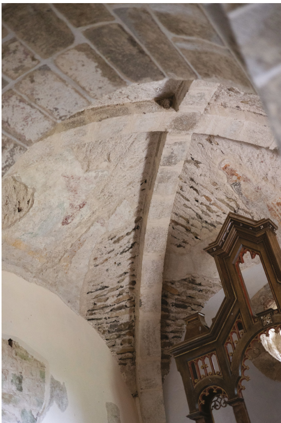
9, 10/ Klenba s hranolovými žebry v presbytáři.
