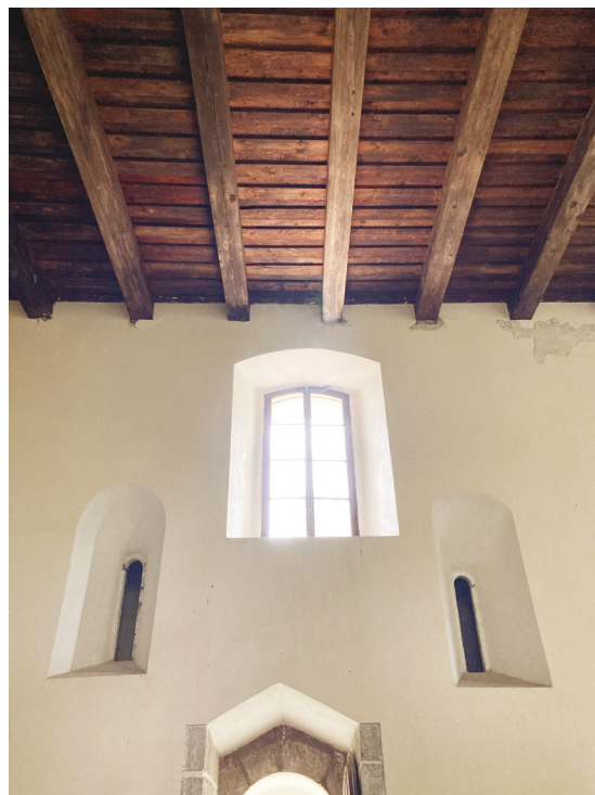
6/ Románská okénka a vchod v jižní zdi lodi.
