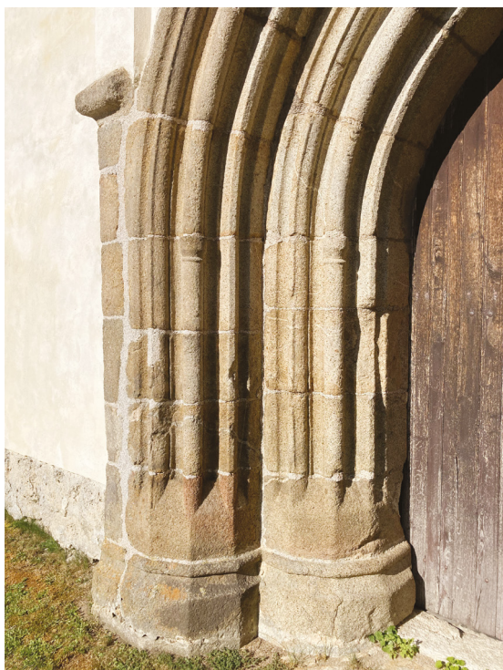
48/ Portál v západním průčelí.
