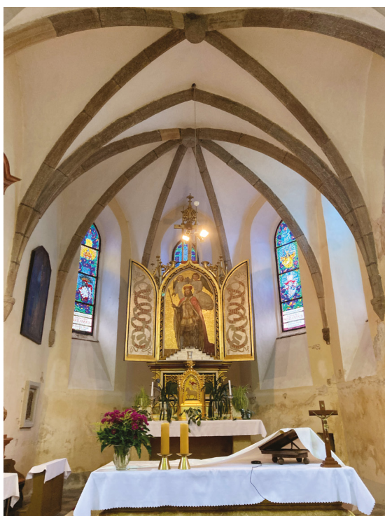
58/ Presbytář s křížovou žebrovou klenbou a konzolami.
