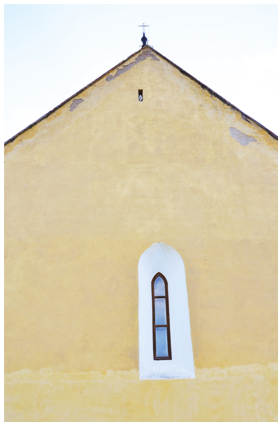
64/ Úzké hrotité okno ve východní zdi presbytáře.
