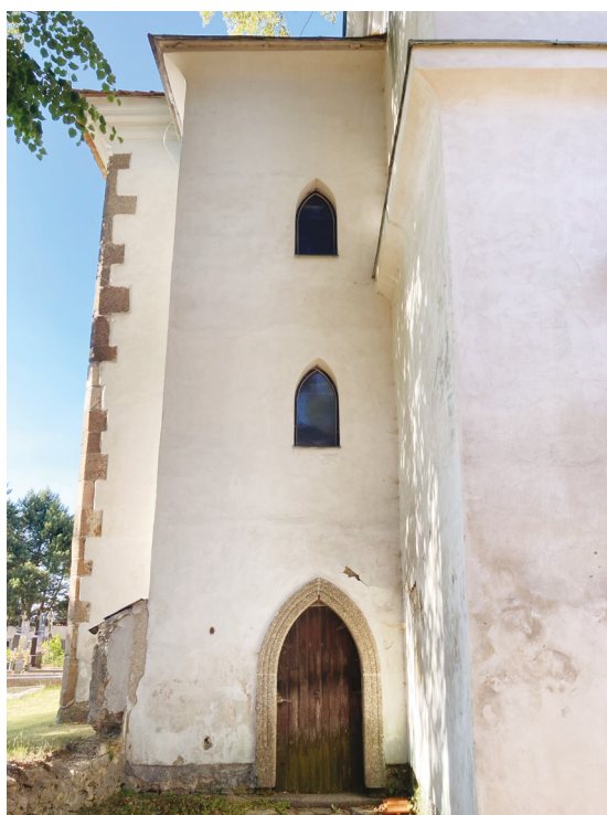
54/ Přístavek se schodištěm do věže na její západní straně.
