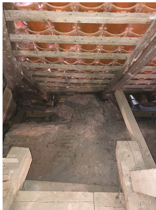
44/ Klenba jižního ramena transeptu.
