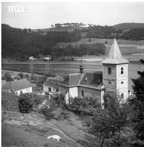
71/ Kostel sv. Štěpána v Těchnicích, celkový pohled od jihozápadu, 1955.
