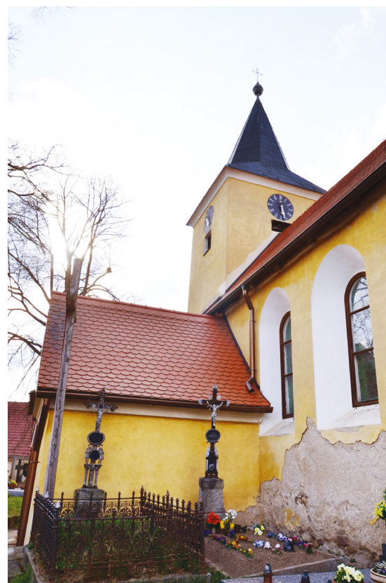
62/ Okna presbytáře a jižní předsíň.
