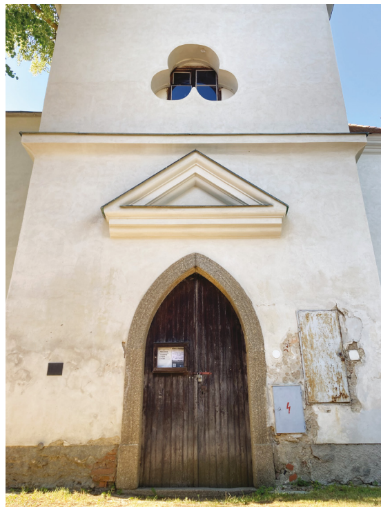
51/ Portál do podvěží.
