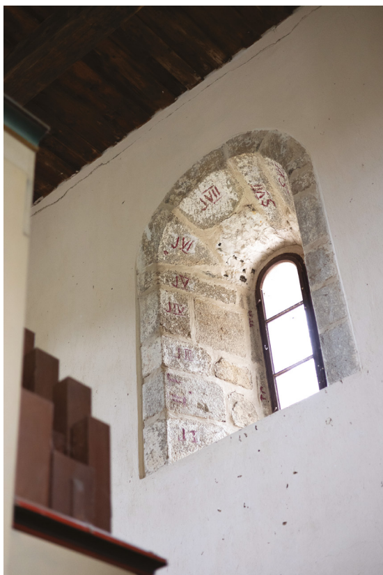
3/ Okno v západním průčelí lodi.
