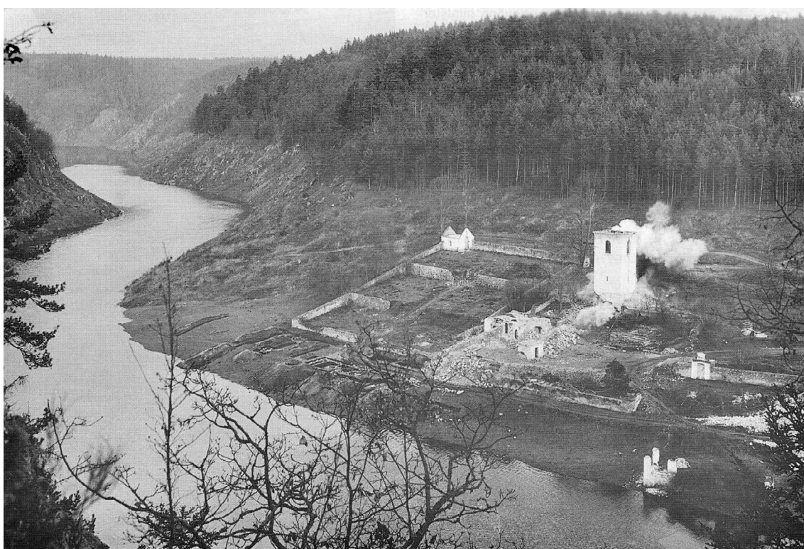
18/ Odstřel věže po dokončení demolice, 12. prosince 1960.
