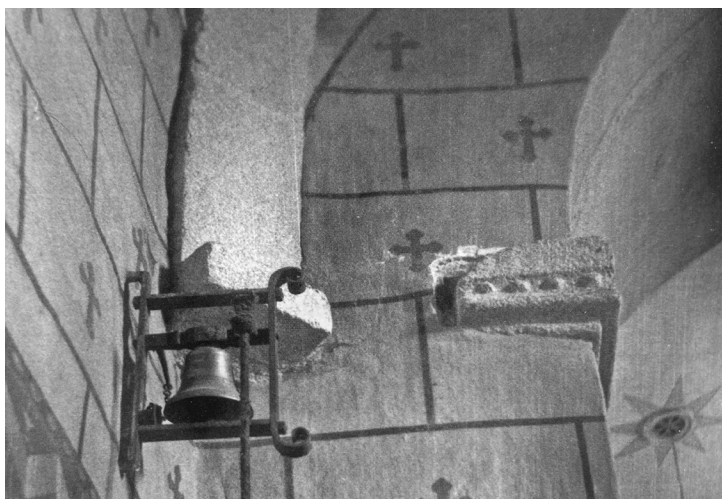
15/ Historizující výmalba presbytáře, 1959.
