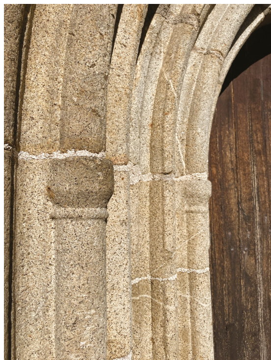
49/ Detail portálu v západním průčelí.
