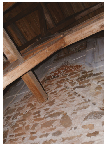
28/ Pozůstatky původního zastřešení v západním štítu lodi.
