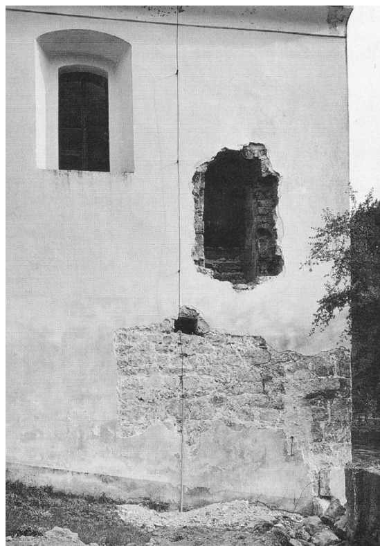
12/ Odhalený vchod na původní tribunu v severozápadním koutě lodi.
