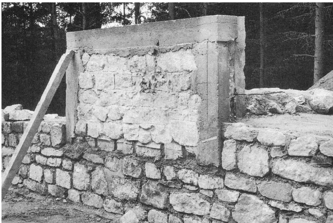
17/ Přenášení kamenných bloků během přesunu kostela, 1960.
