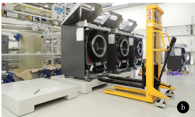
obr. 5–17: Železobetonové podstavce: (a) rozměrový náčrtek, (b) usazování praček na podstavce pomocí vysokozdvizného vozíku
