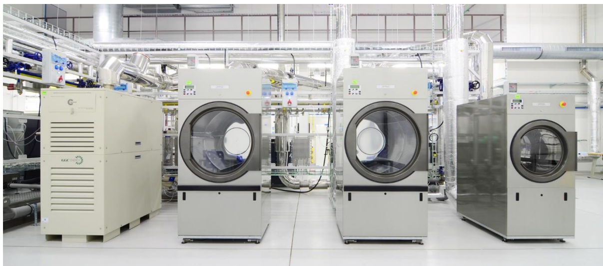
obr. 5-5: Sestava bubnových sušičů a plynová mikroturbína (zcela vlevo)
