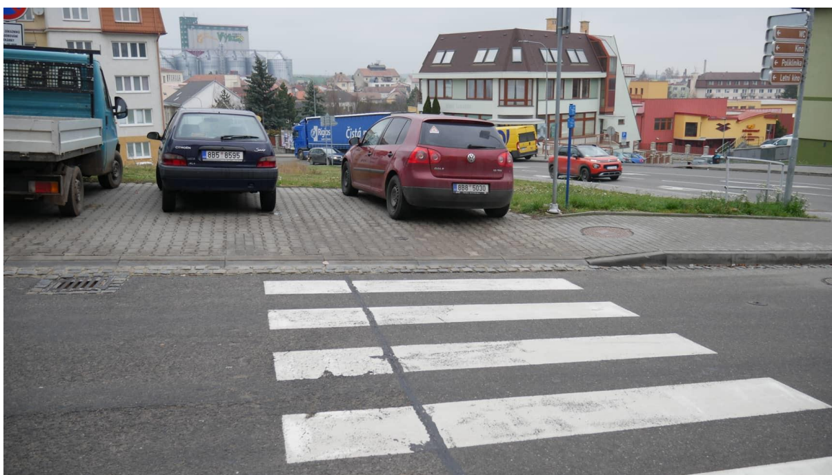
Obrázek 8.16 Sjezd přes přechod pro chodce
