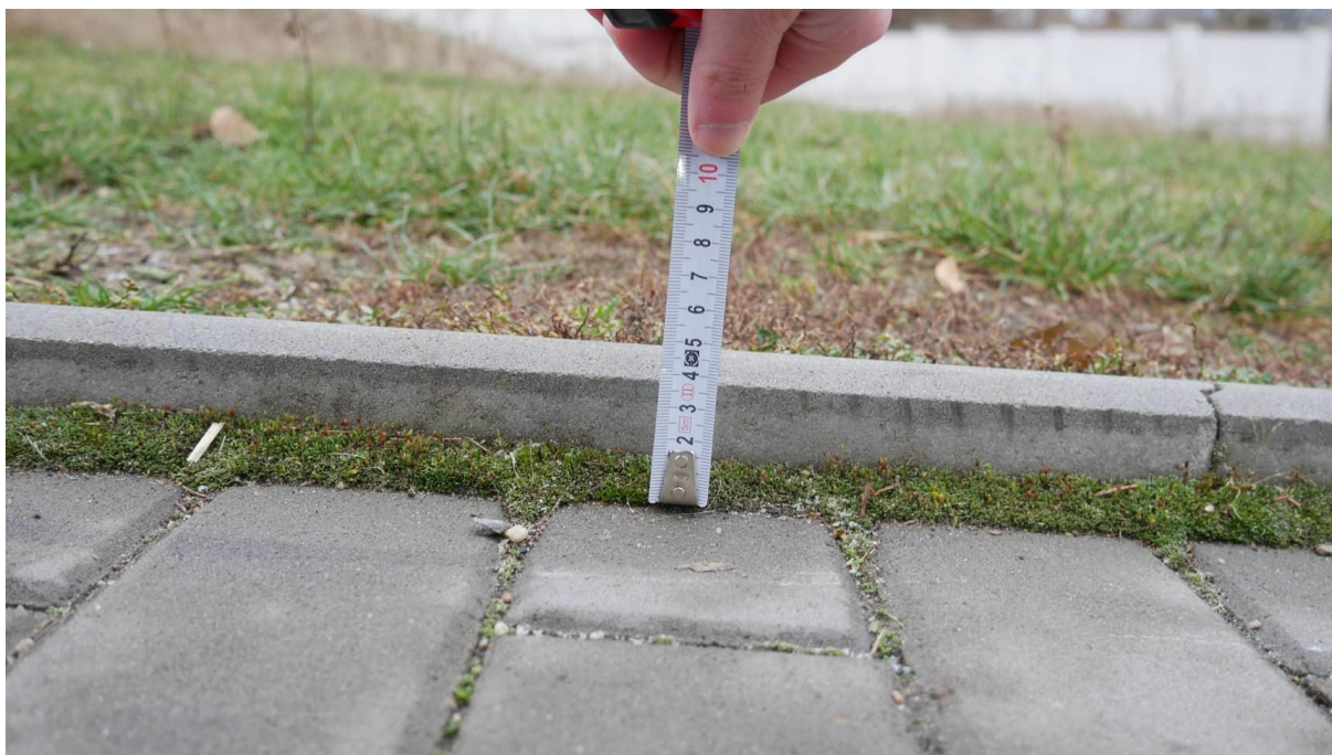
Obrázek 8.28 Nedostatečné převýšení obrubníku trávníku
