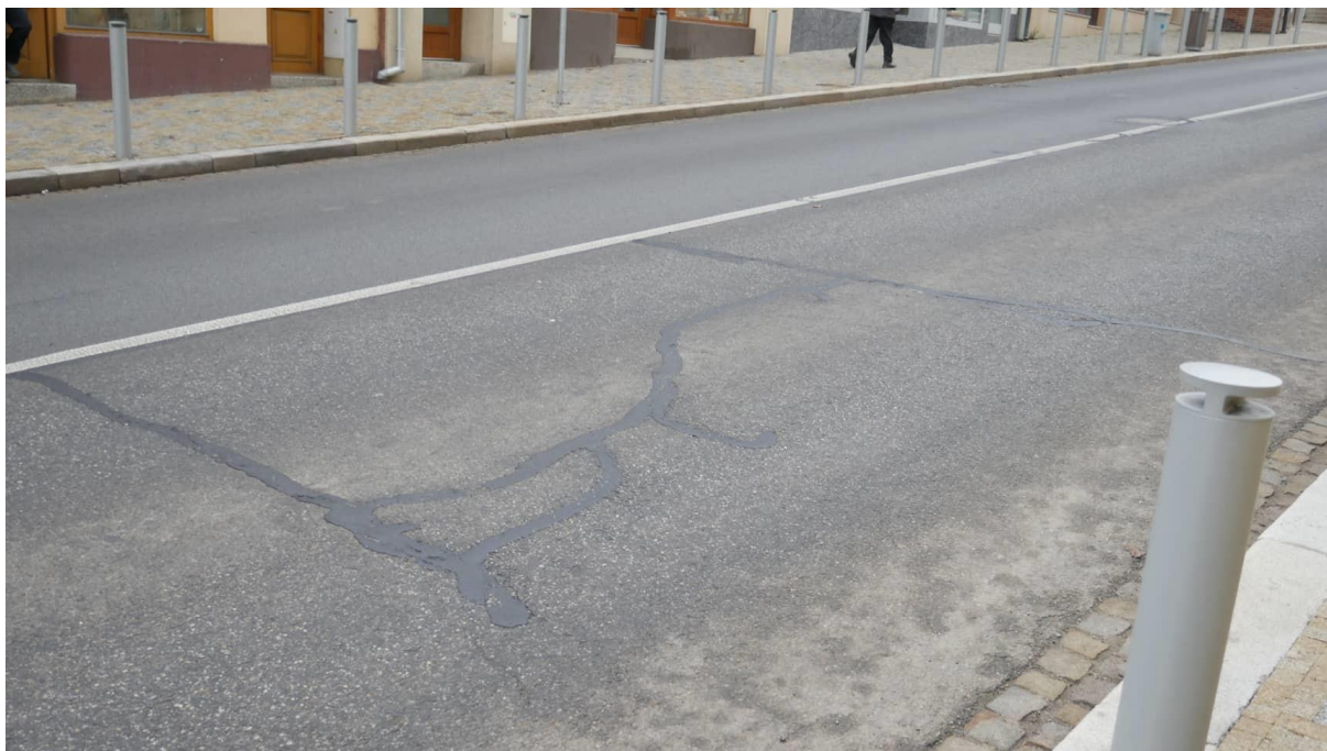
Obrázek 8.12 Vysprávký po podélných a příčných trhlinách (1. Máje sever směr od křižovatky)
