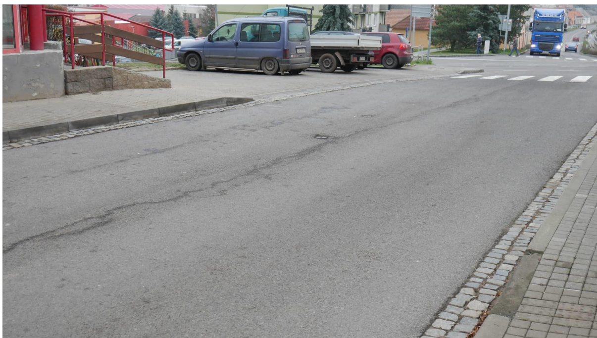
Obrázek 8.12 Vysprávký po podélných a příčných trhlinách (1. Máje sever směr od křižovatky)
