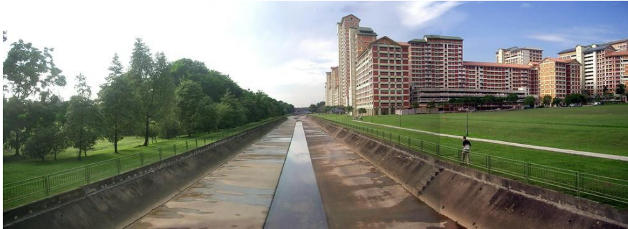
Obrázek 16 Koryto řeky Kallang před revitalizací (World Architecture News, 2012)
