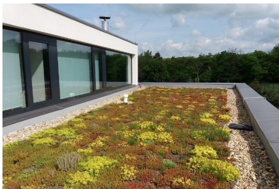
Obrázek 12 Vegetační střecha (Dostal P., 2020)
