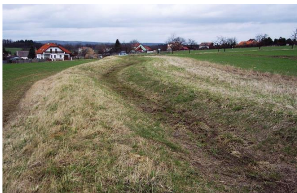
Obrázek 1 Protierozní průleh s hrázkou (Kadlec V., 2014)
