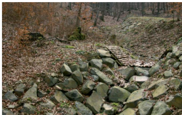
Obrázek 8 Strž stabilizovaná konstrukcí z kulatiny a kamennou výplní (Vokurka A., Zlatuška K., 2020)
