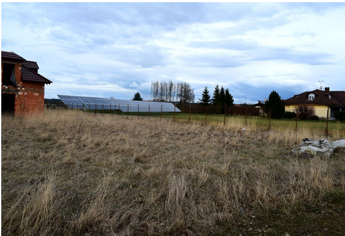
Obr. 62: FVE patřící společnosti ECO Energo s.r.o. lokalizovaná na soukromém pozemku v obydlené části obce Opatovec Zdroj: P. Dřímál (březen 2018)
