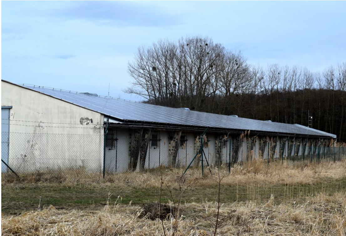
Obr. 61: FVE lokalizovaná na střeše bývalé drůbežárny v k. ú. obce Opatov Zdroj: P. Dřímál (březen 2018)
