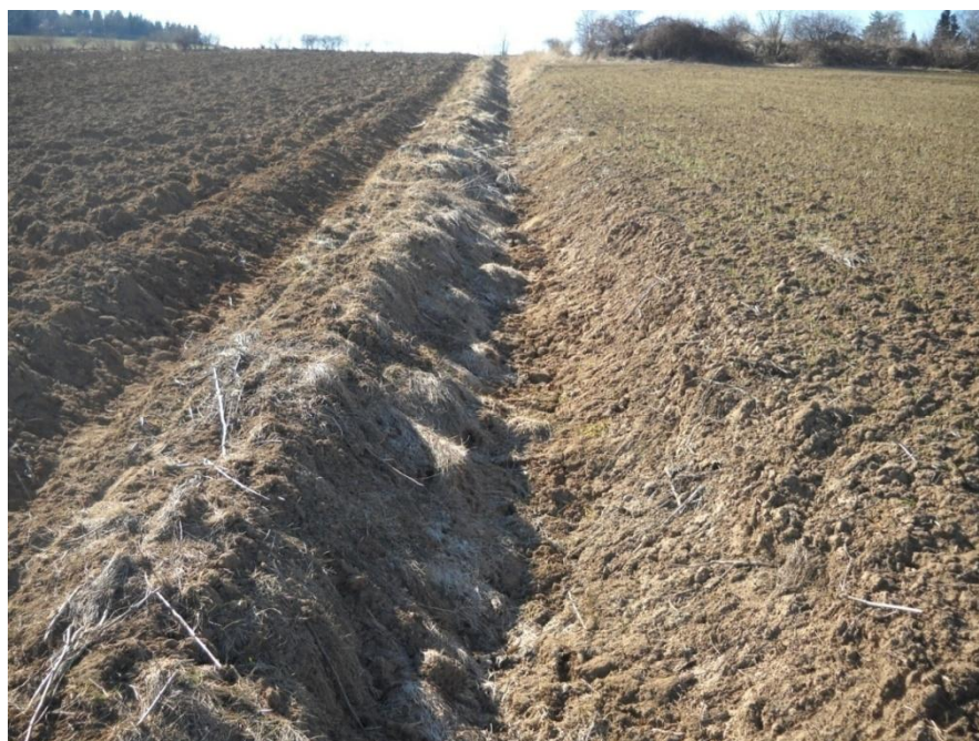
Foto 1 Zanášení příkopu P10 z důvodu chybějícího ochranného zatravnění.
