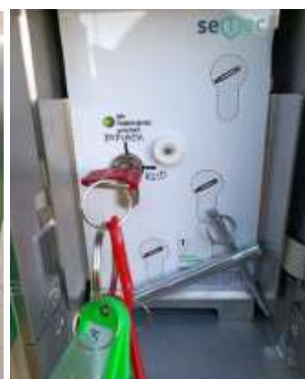
Obr. č.4: Vnitřní prostor KTPO
