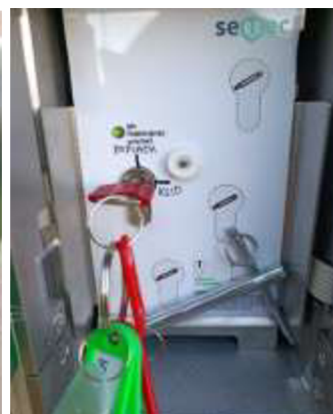
Obr. č.4: Vnitřní prostor KTPO
