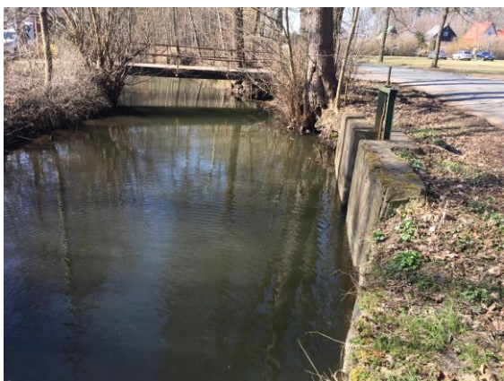
Obr.č.15. Opatovický kanál v Lázních Bohdaneč, po proudu, vpravo odběrný objekt pro Nadymače I.-III.
