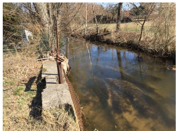
Obr.č.30. Odběrný objekt pro rybníky Malá a Velká Jalůvka
