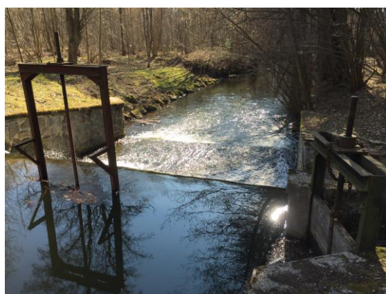
Obr.č.18. Vzdouvací objekt v ř. km 7,17, vpravo vtokový objekt do Sopřečského kanálu
