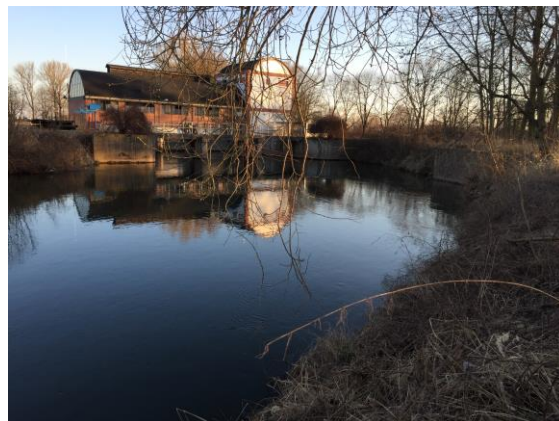
Obr.č.2. Zaslepený původní nátok do Opatovického kanálu, v pozadí MVE na Labi
