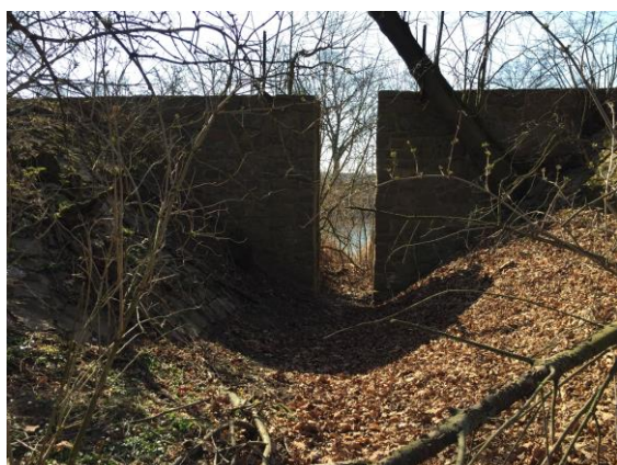
Obr.č.35. Ústí bývalého koncového úseku do Labe
