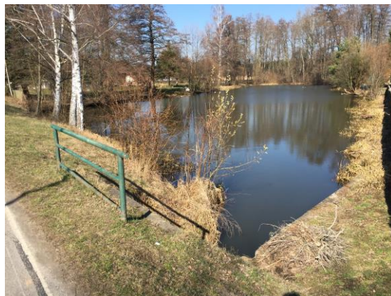
Obr.č.32. Pohled z hráze na rybník Malá Jalůvka
