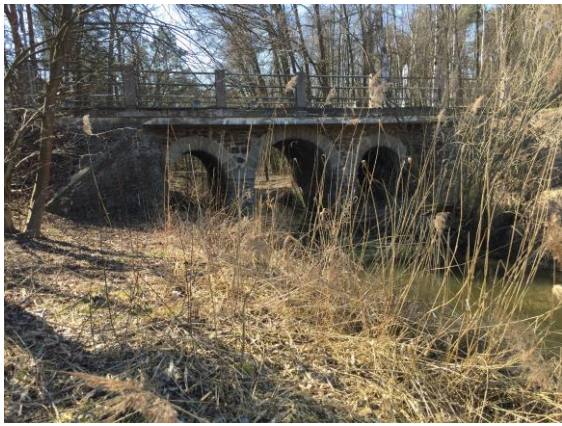
Obr.č.25. Most přes Sopřečský potok, pozůstatek hráze po zaniklém Žernovském rybníku
