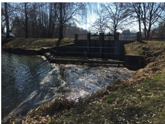
Obr.č.13. Výpustní objekt Bohdanečského rybníka
