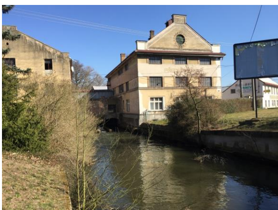
Obr.č.17. Budova Předního mlýnu v Lázních Bohdaneč, v současnosti obnoven provoz MVE
