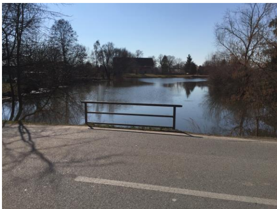
Obr.č.31. Pohled z hráze na rybník Velká Jalůvka
