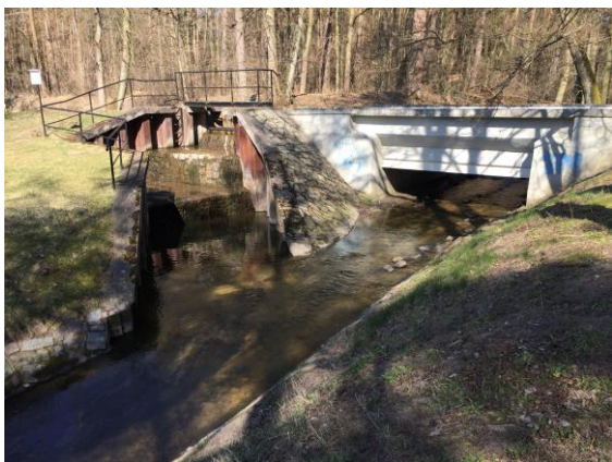
Obr.č.29. Akvadukt u Semína, pohled z levého břehu Sopřečského potoka
