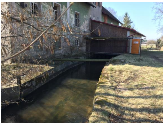
Obr.č.33. Koryto Opatovického kanálu na vtoku do objektu MVE v Semíně
