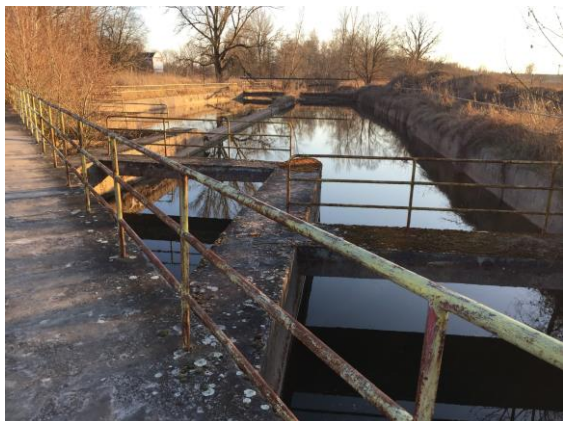
Obr.č.1. Nátokový objekt Opatovického kanálu na Labi
