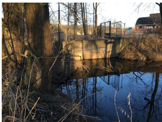
Obr.č.3. Zaslepený původní nátok do Opatovického kanálu, vpravo MVE na Labi
