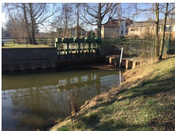
Obr.č.5. Ždánická stavidla v Opatovicích nad Labem
