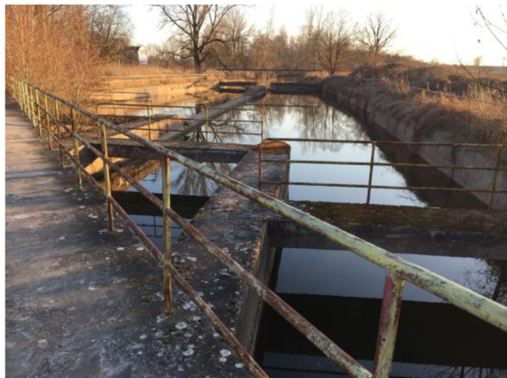
Obr.č.1. Nátokový objekt Opatovického kanálu na Labi
