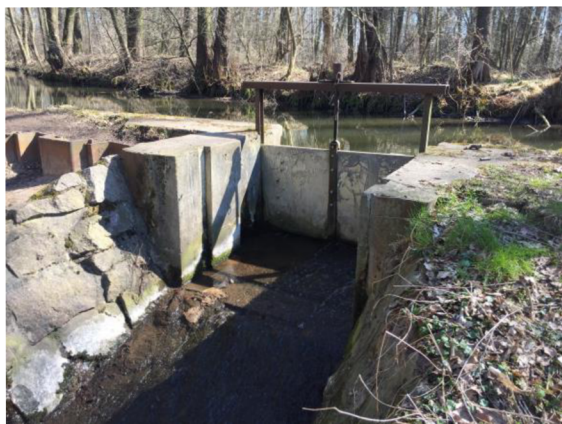
Obr.č.7. Vtokový objekt pro přívodní strouhu do Bohdanečského rybníka.
