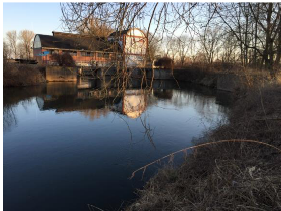
Obr.č.2. Zaslepený původní nátok do Opatovického kanálu, v pozadí MVE na Labi
