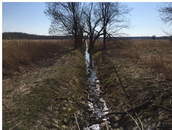
Obr.č.22. Koryto Sopřečského potoka, pohled z jižní hráze Sopřečského rybníka, v místě výpustného objektu
