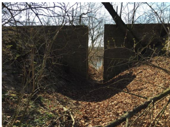
Obr.č.35. Ústí bývalého koncového úseku do Labe
