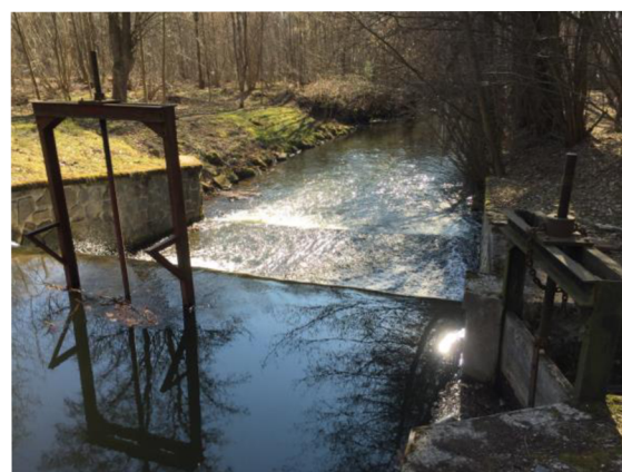
Obr.č.18. Vzdouvací objekt v ř. km 7,17, vpravo vtokový objekt do Sopřečského kanálu
