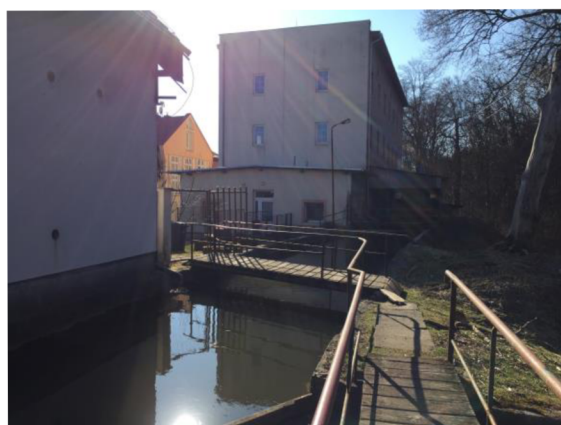
Obr.č.27. Nátok Opatovického kanálu do MVE v obci Břehy - Výrov
