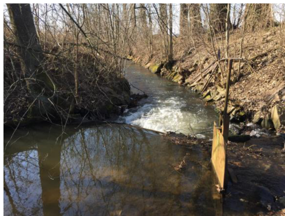
Obr.č.34. Koryto Opatovického kanálu pod Semínem, vpravo nátok do bývalého koncového úseku
