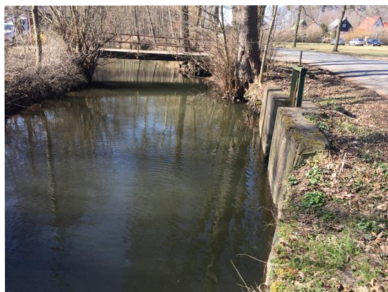
Obr.č.15. Opatovický kanál v Lázních Bohdaneč, po proudu, vpravo odběrný objekt pro Nadymače I.-III.
