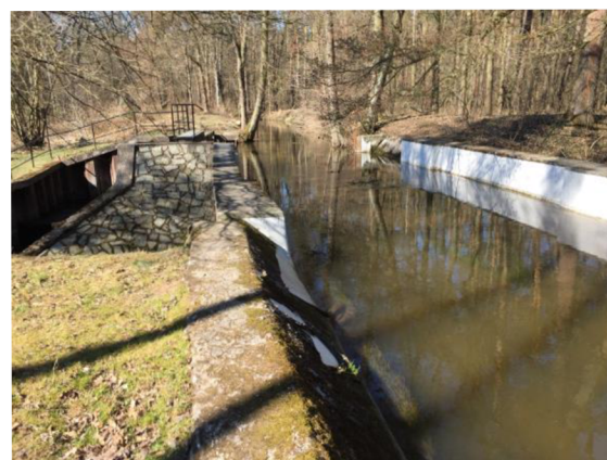
Obr.č.28. Akvadukt u Semína, pohled z levého břehu Opatovického kanálu
