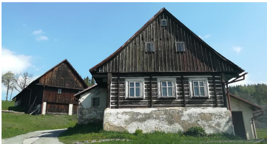
Obrázek 9 Tradiční lidová architektura – roubené stavby
