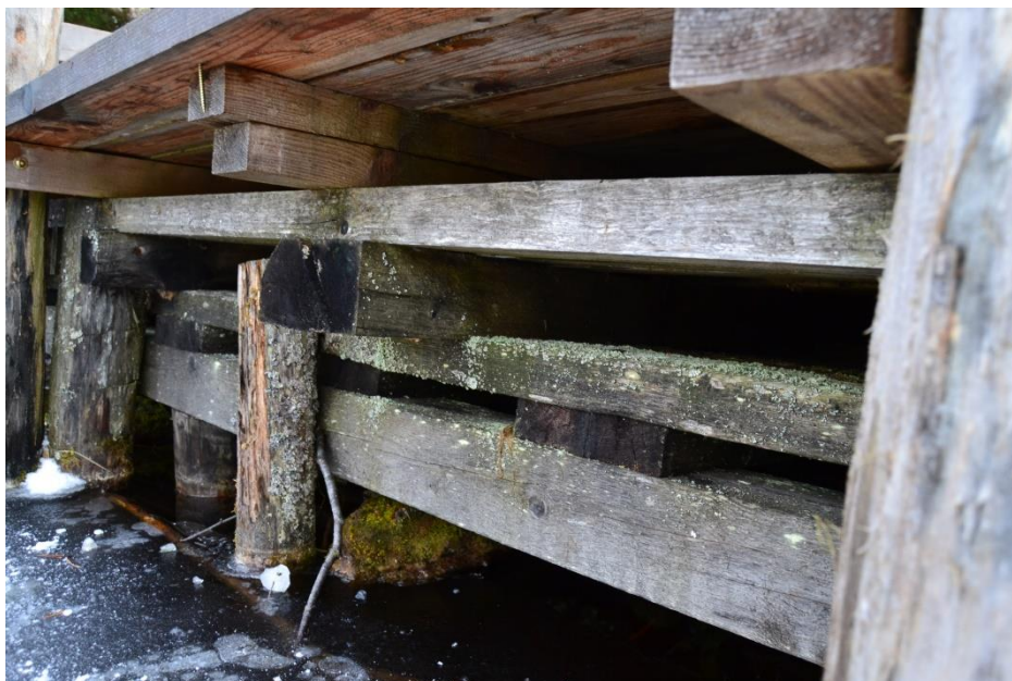
Příloha 7 - Ukázka konstrukce vyhlídkové plochy, která se nachází na konci povalového chodníku v Chalupské slati. Foto: Autor
