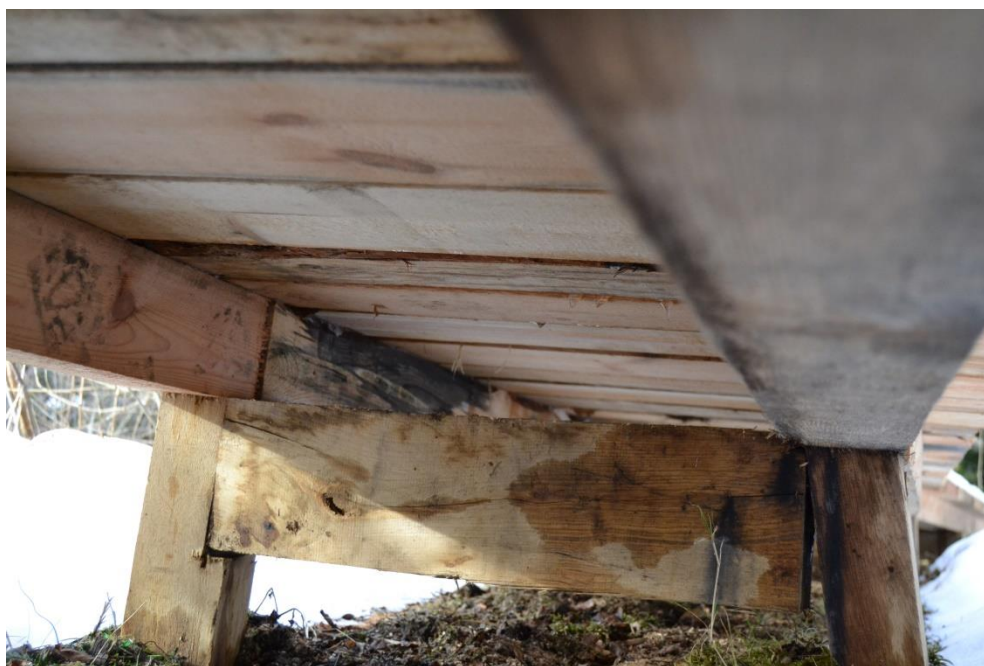
Příloha 6 - Povalový chodník na Hornovltavských pastvinách. Z detailu vyfocené využití pivotů v terénu (II.). Foto: Autor
