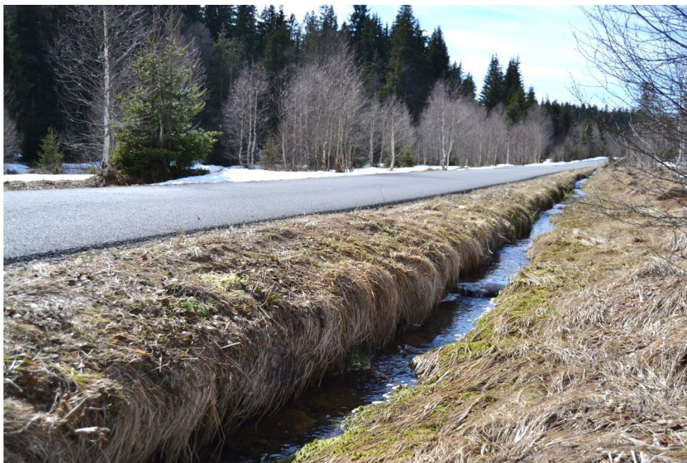
Obrázek 23 - Asfaltový chodník vedoucí z Modravy na Javoří pilu s odtokovým kanálem. Foto: autor
