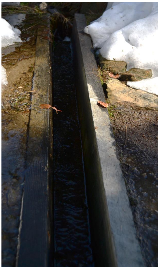
Příloha 9 - Dřevěná svodnice na kamenném chodníku na Velký ostrý. Foto: Autor
