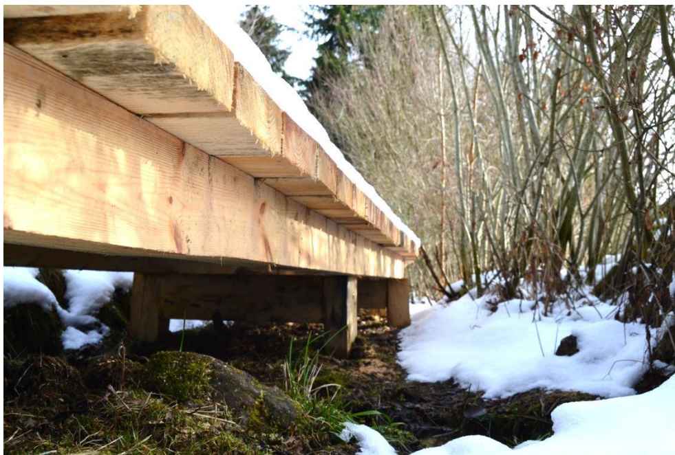
Příloha 5 - Povalový chodník na Hornovltavských pastvinách. Z detailu vyfocené využití pivotů v terénu (I.). Foto: Autor
