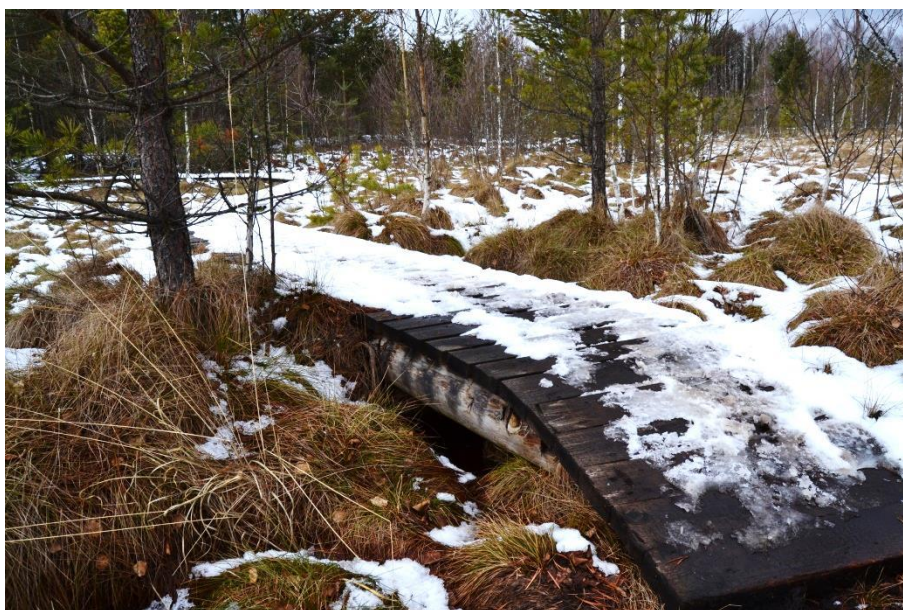
Obrázek 4 - Povalový chodník s rampou umožňující vstup pro vozičkáře, nad Soumarským rašeliništěm v zimním období (působení sněhové eroze). Foto autor
