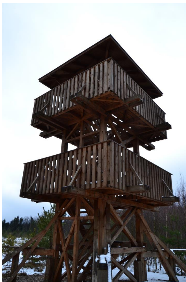
Příloha 8 - Dřevěná vyhlídková věž v Soumarském rašeliništi, která byla vybudována společně s povalovým chodníkem. Foto: Autor
