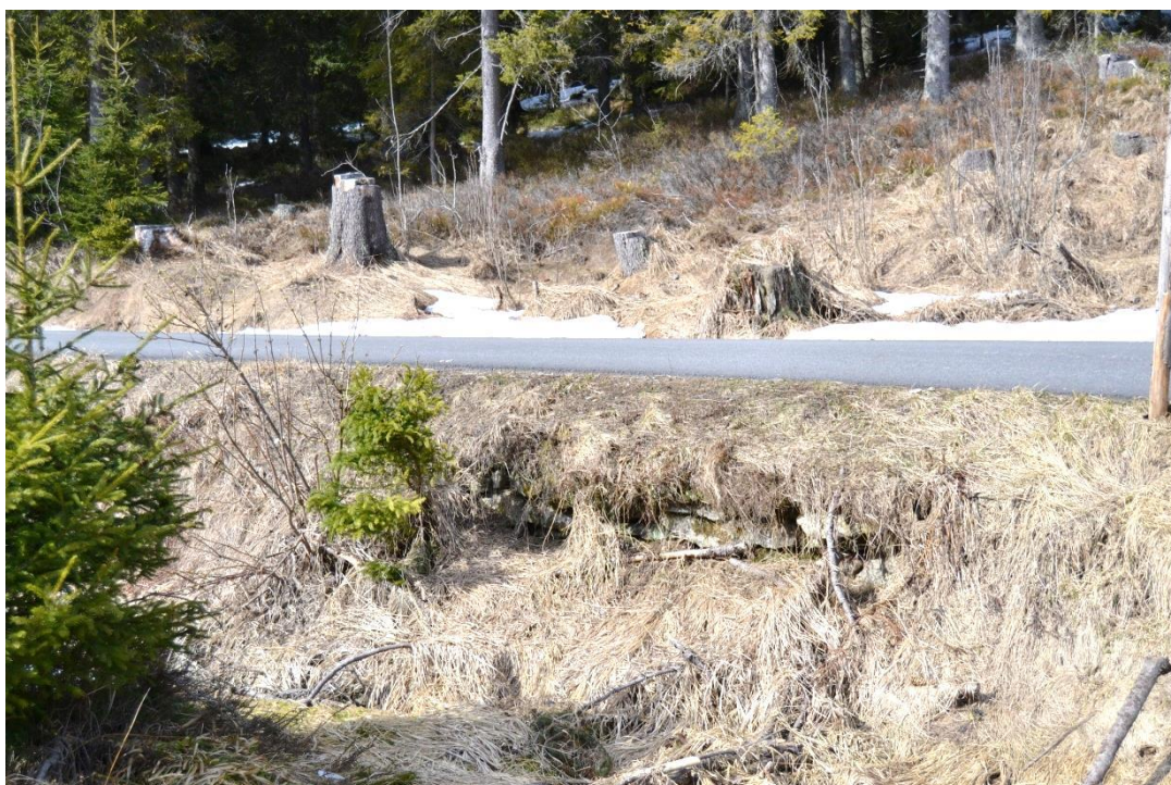
Obrázek 22 - Asfaltový chodník na Modravě, který se nachází na násypu. V odkryté trávě lze vidět kameny zpevňující podklad chodníku. Foto: Autor
