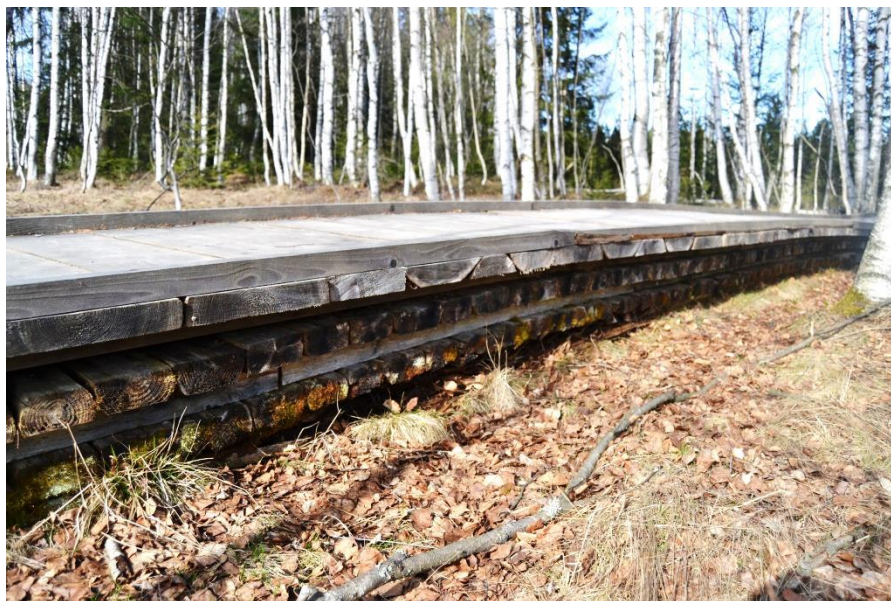
Obrázek 11 - Povalový chodník na Chalupské slati z profilu, na kterém lze vidět staré opotřebené chodníky. Foto: autor
