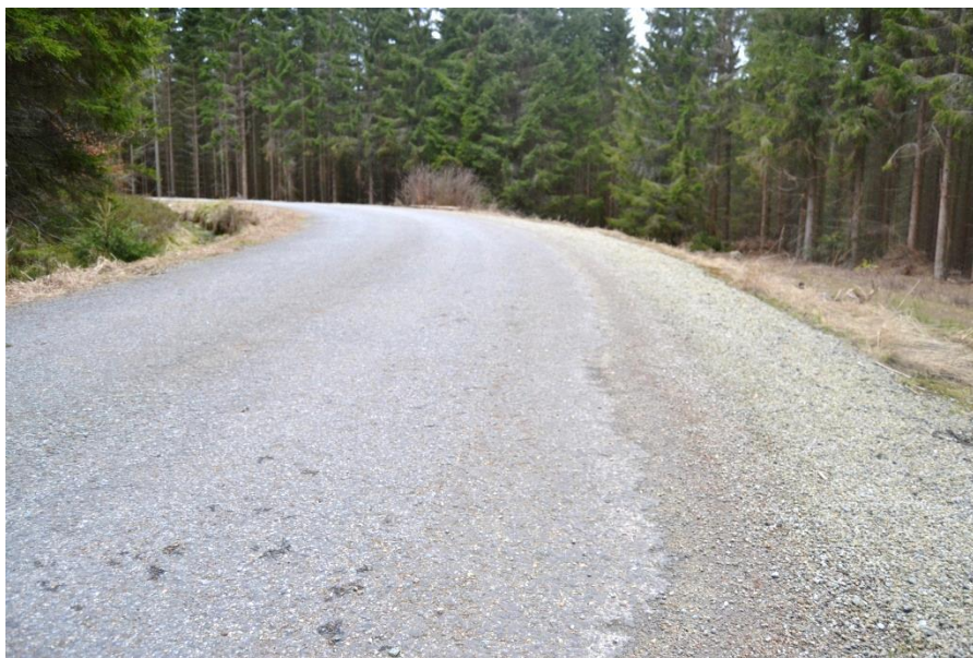
Obrázek 19 - Asfaltový chodník okolo Schwarzenberského plavebního kanálu z detailu. Šíře chodníku na tomto místě cca 4m z toho 3 metry asfalt a 1m štěrk. Foto: Autor
