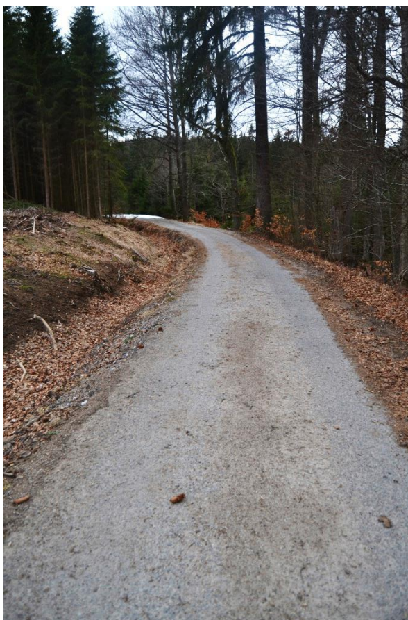
Obrázek 18 - Asfaltový chodník okolo Schwarzenberského plavebního kanálu. Levotočivá zatáčka s mírně nakolným povrchem zajišťující odtok povrchové vody. Foto: Autor
