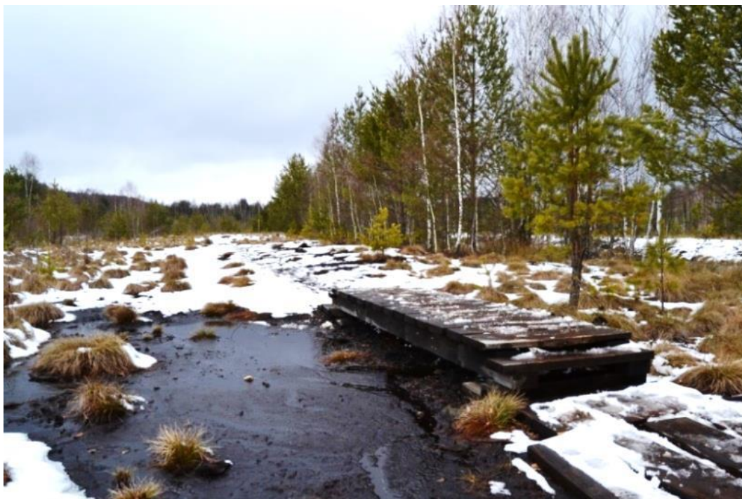
Obrázek 8 - Povalový chodník v Soumarském rašelišti vyvýšený pomocí pivoťů. Foto: Autor
