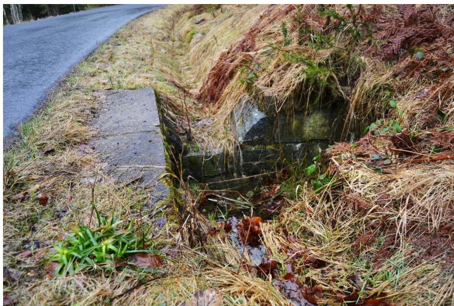
Příloha 2 - Odvodňovací jáma u asfaltového chodníku. Foto: Autor
