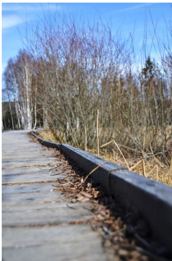
Obrázek 12 - okrajová lišta na povalovém chodníku v Chalupské slati. Lišta zabraňující organickému materiálu k opuštění chodníku. Foto: autor
