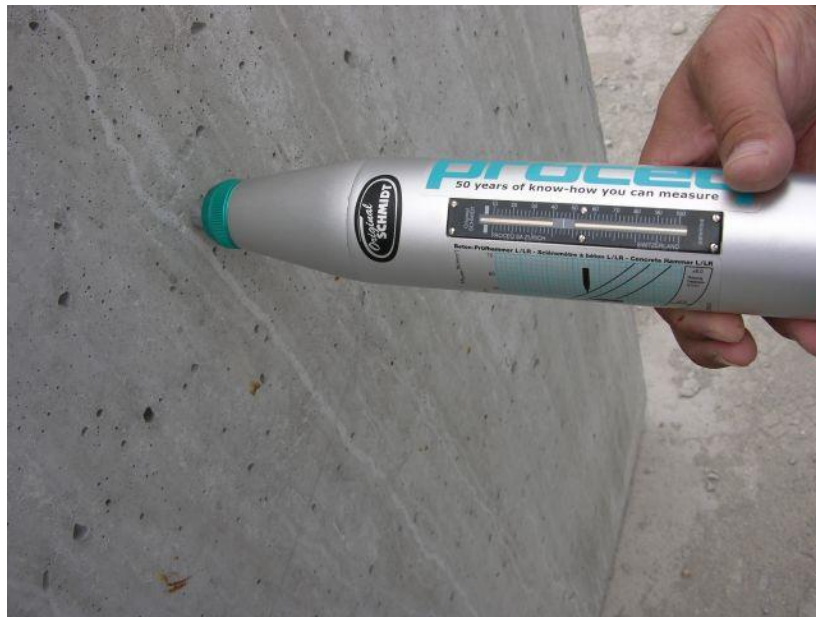
Obrázek 89 – Kontrola pevnosti betonu [48]
