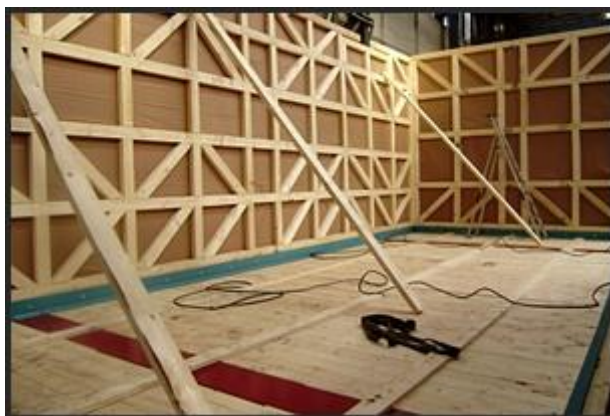
Obrázek č. 8: Montáž ochranného obalu pro turbogenerátor
