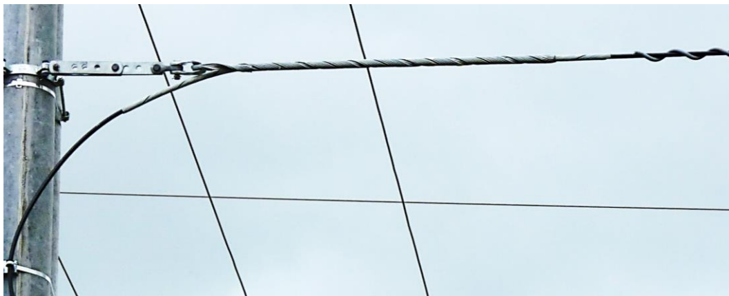
Obrázek 9: Detail kotevního závěsu SDOK
