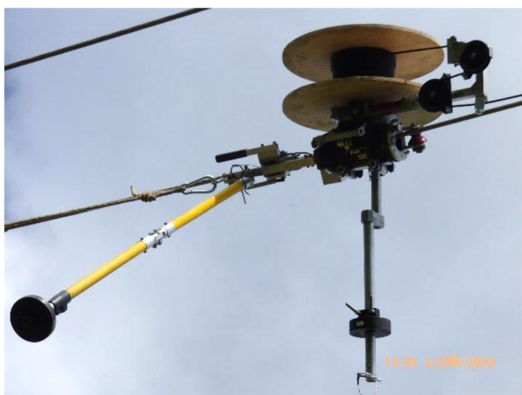
Obrázek 18: Přípravek pro ovíjení optického kabelu
