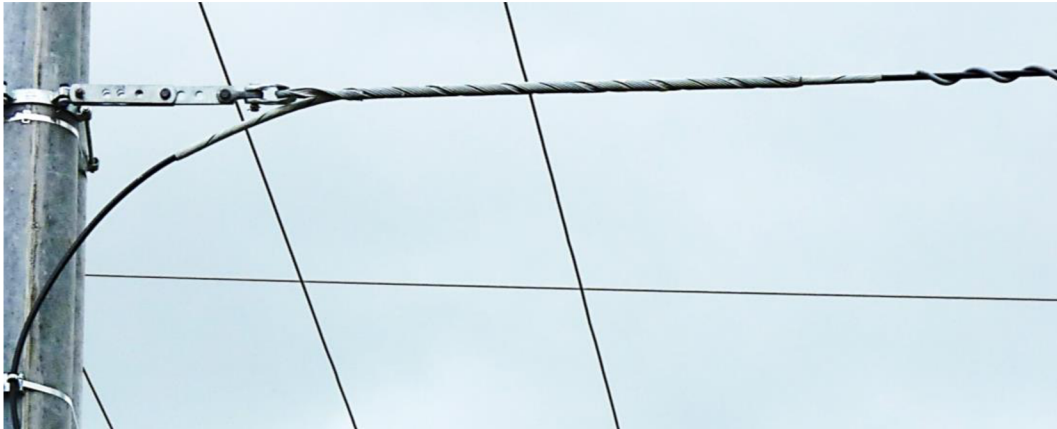
Obrázek 9: Detail kotevního závěsu SDOK
