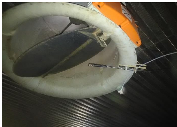
Obrázek 3.5: Umístění vrtulkové sondy
