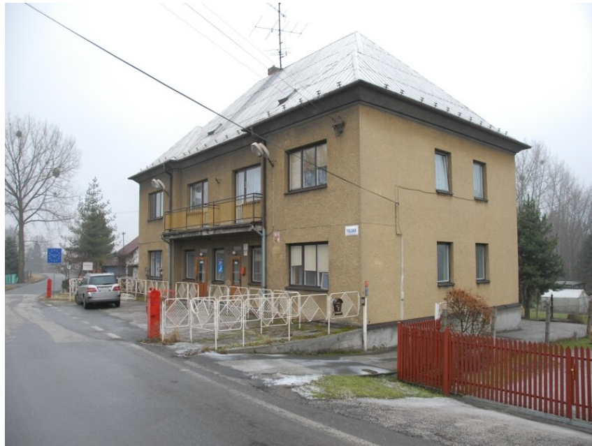
Fotografie původního objektu obytného domu před rekonstrukcí.
