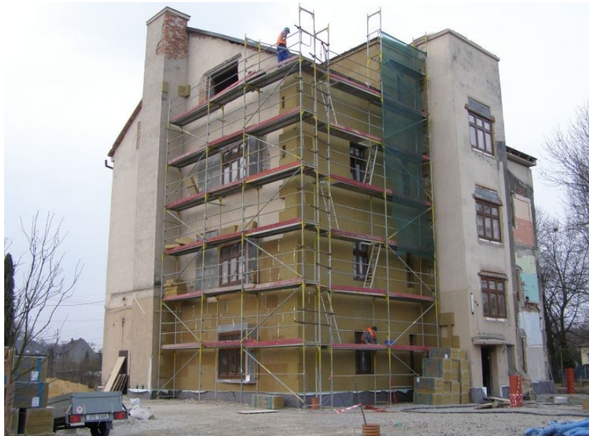
Zahájení rekonstrukce Domova Jistoty v roce 2011.
