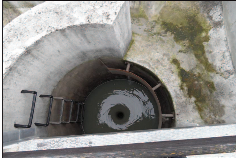
Obr. 19 Vírový separátor
