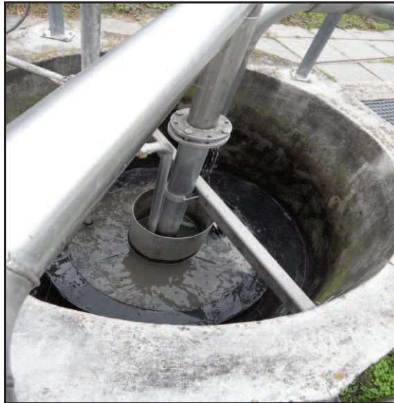
Obr. 22 Vertikální lapák písku
