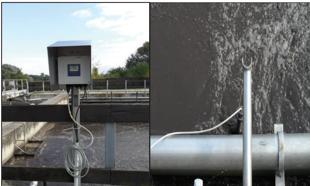
Obr. 27 Kyslíková sonda v nitrifikační nádrži
