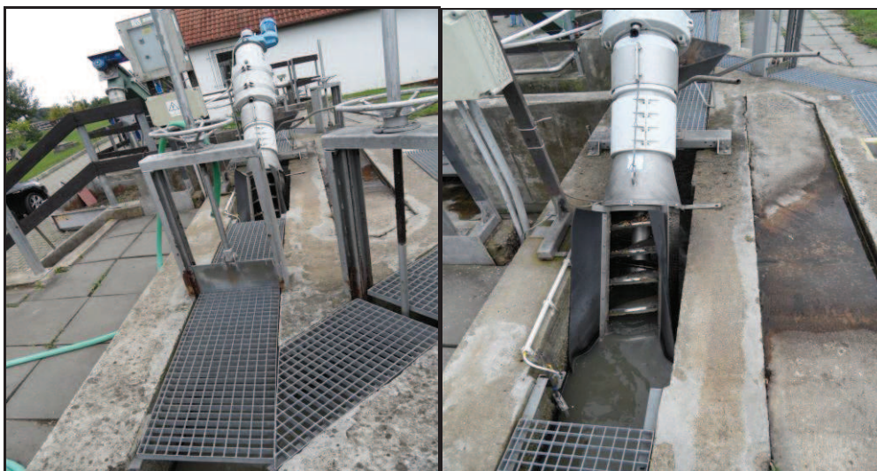
Obr. 21 Jemné česle se šnekovým dopravníkem shrabků
