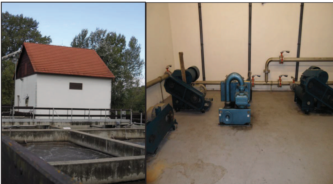
Obr. 29 Dmychárna a její vnitřní prostor
