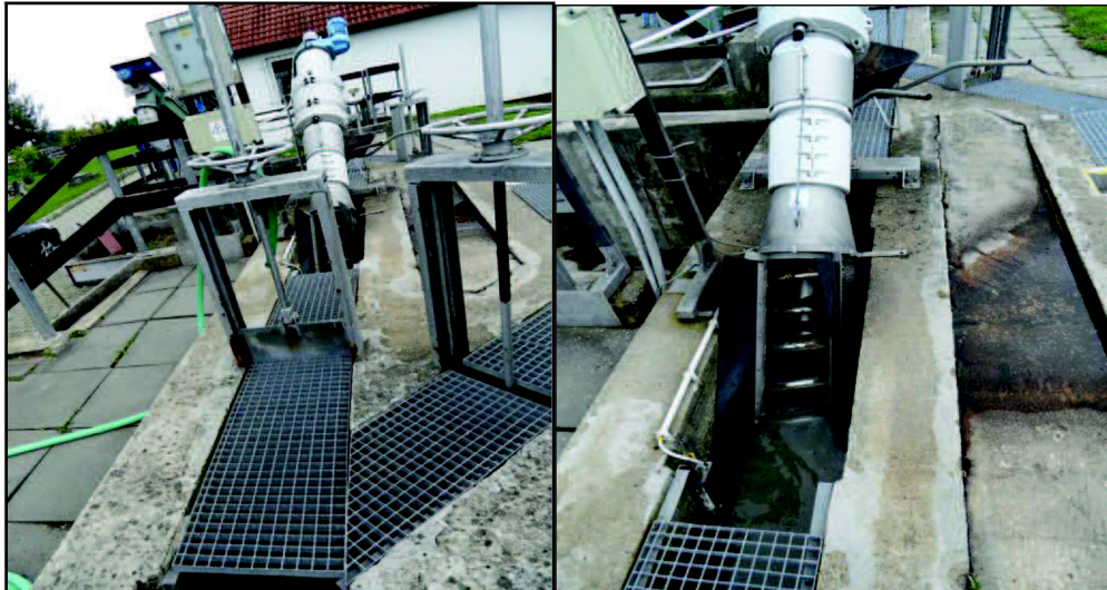
Obr. 21 Jemné česle se šnekovým dopravníkem shrabků
