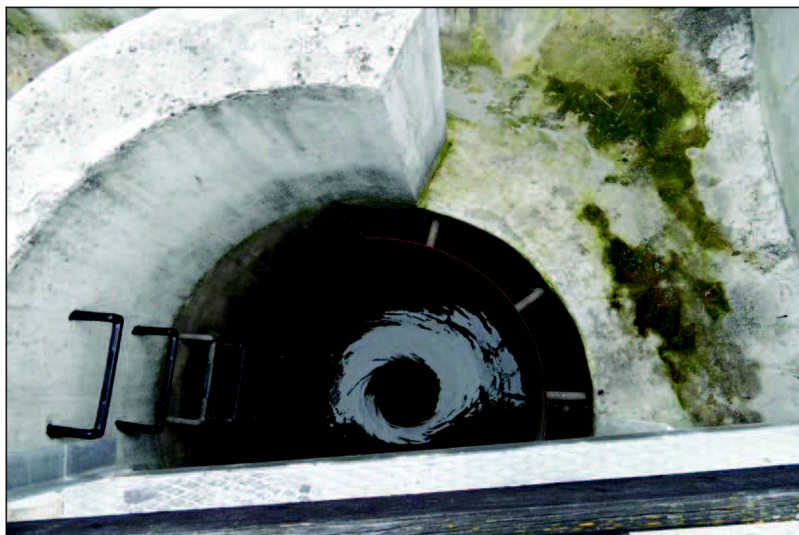
Obr. 19 Vírový separátor
