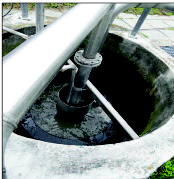
Obr. 22 Vertikální lapák písku
